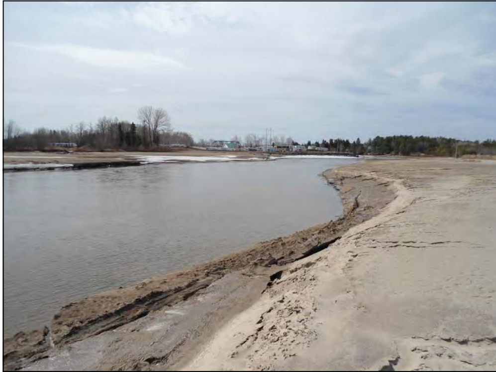
Photo 1. Avril 2013. Vue vers l'amont de l'embouchure de la Belle Rivière au niveau de l'élargissement du cours d'eau (après le camping L'Évasion)
