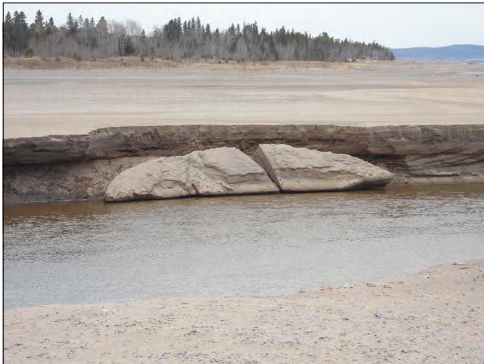
Photo 8. Avril 2013. Lit instable dans la zone de marnage du lac Saint-Jean
