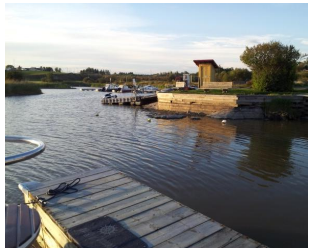
Photo 24 : Installations de la marina à la côte minimale de 13 pieds
