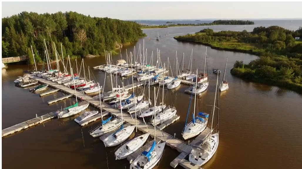
Photo 4 : Vue d'ensemble de la marina et du chenal donnant accès au lac
