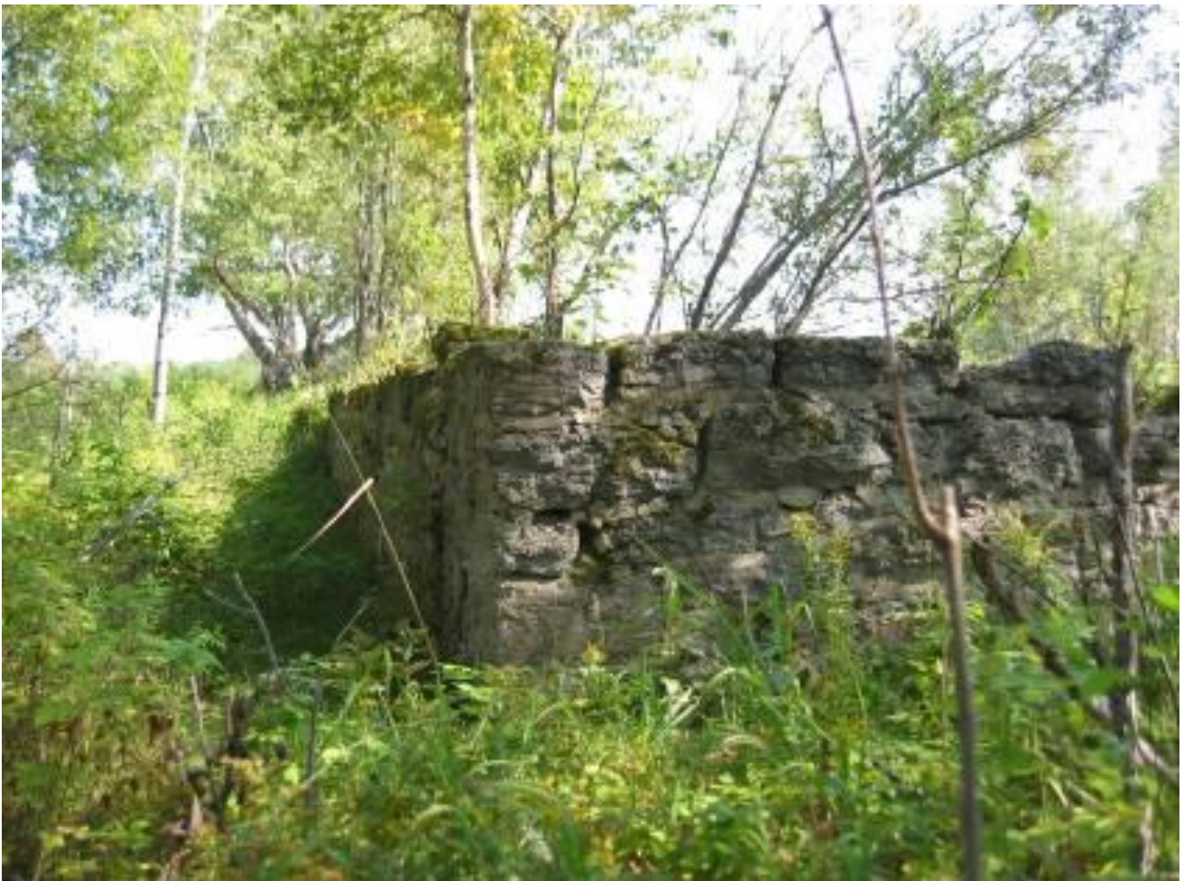
Figure 42 – Fondation de la grande-étable du Domaine Normand sur l'île Bouliane.
