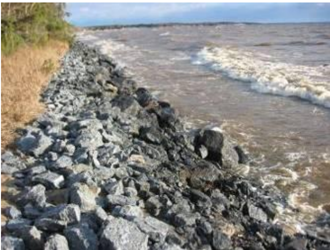
Figure 3 – Structure de stabilisation de la berge (perré) au parc national de la Pointe-Taillon.
