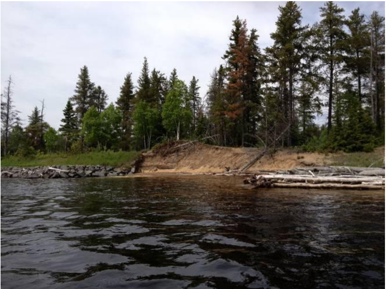
Figure 25 – Érosion de la berge à l'extrémité est du perré du lac à la Tortue
