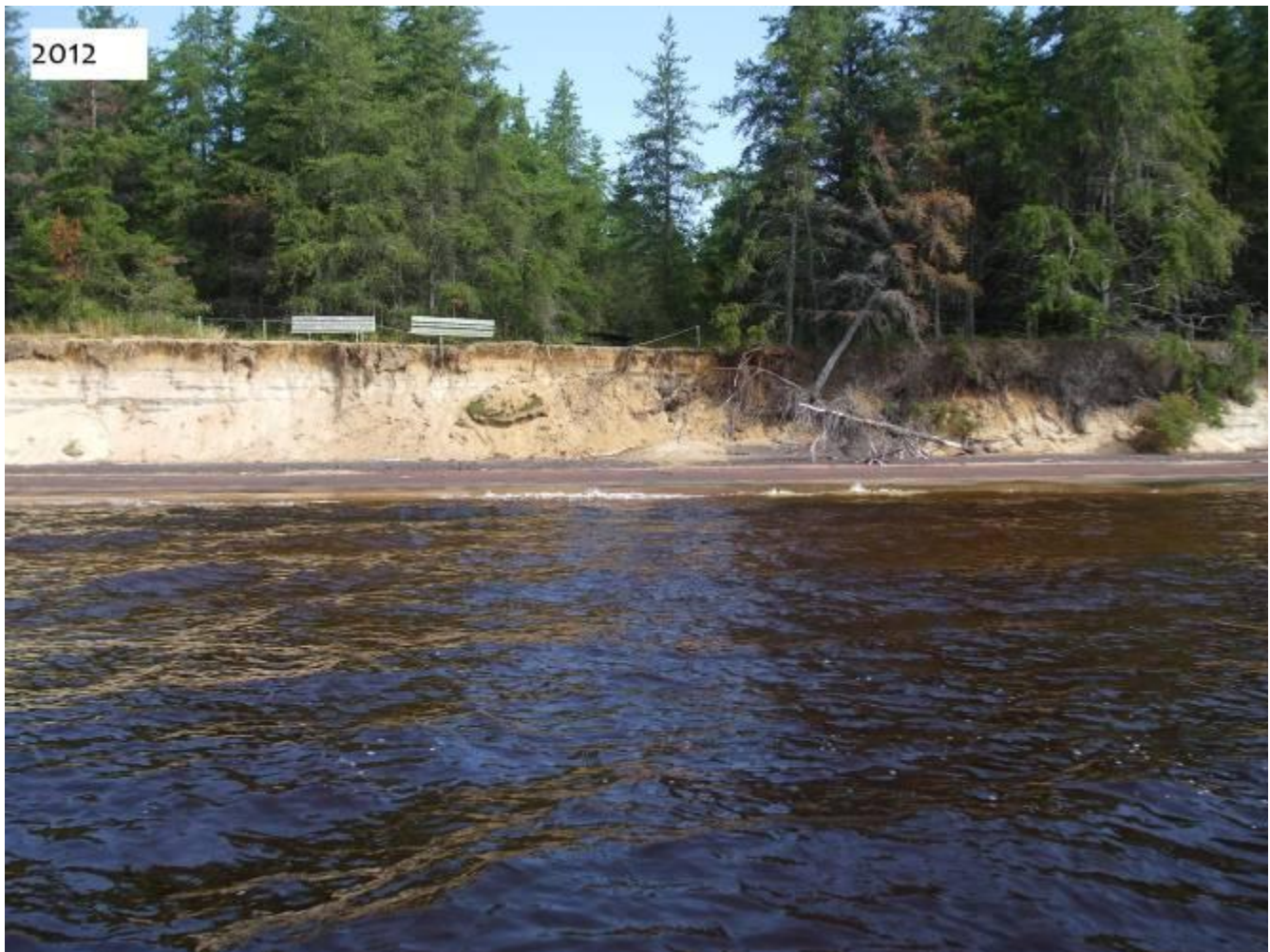
Figure 24 – Halte cycliste aménagée au km 5 de la piste cyclable affectée par l'érosion de la berge.
