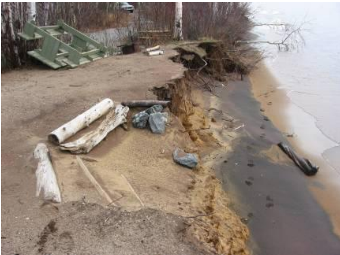
Figure 23 – Site de camping délaissé en raison de l'érosion de la berge.
