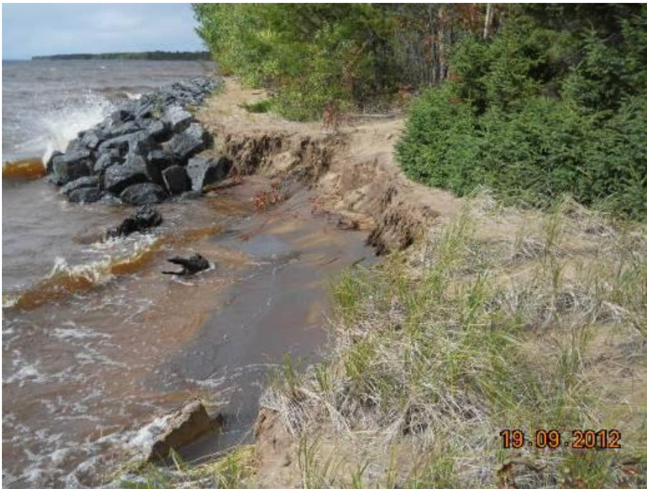
Figure 18 - Érosion de la berge à l'extrémité est du perré situé au km 1 de la piste cyclable à l'automne 2012.
