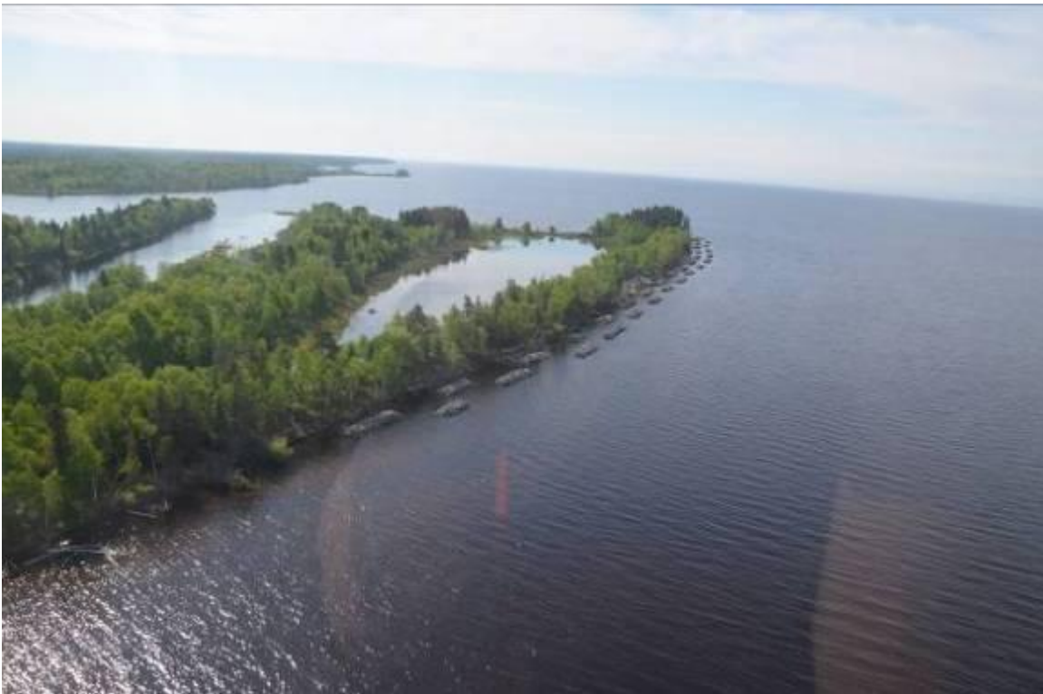
Figure 32 – Stabilisation de la berge par des ilots de roches déversées, étang Anonyme 22. (crédit photo : RTA)
