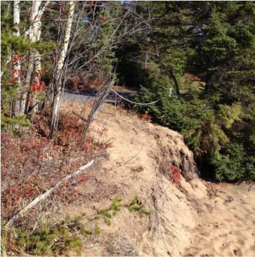
Figure 19 - Piste cyclable du parc menacée par l'érosion de la berge (extrémité est du perré - km 1).
