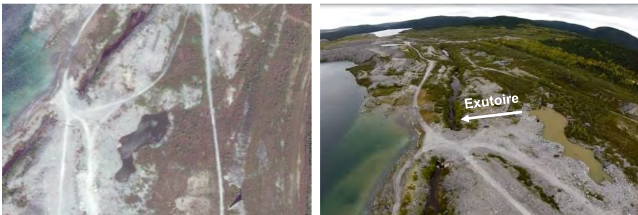
Photo 8. Photographies de la mare près de la fosse 1
