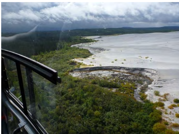
Photo 3. Vue générale du parc à résidus (secteur à l'est)
