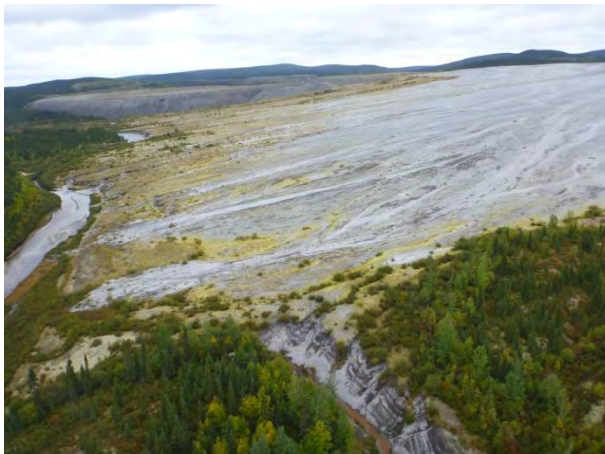
Photo 1. Vue générale du parc à résidus (secteur à l'ouest)
