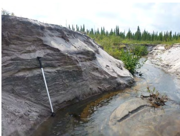
Photo 38. Émissaire du lac du Gneiss Tacheté (talus en érosion)
