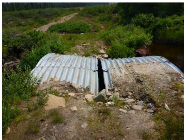
Photo 10. Segment 2, section de ponton désaffecté (vue du dessus)
