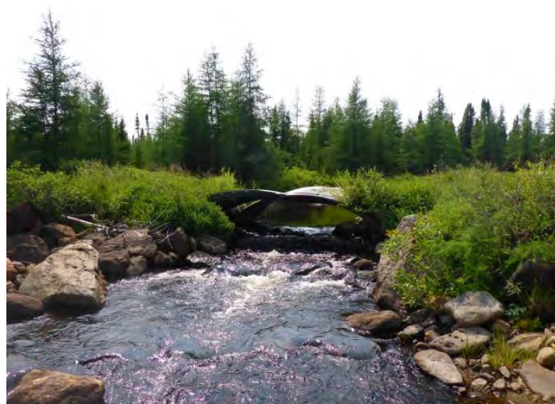
Photo 9. Segment 2, section de ponton désaffecté (vue aval)
