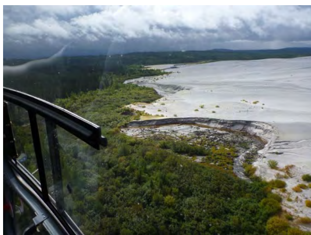
Photo 15. Vue générale du parc à résidus (secteur à l'est)
