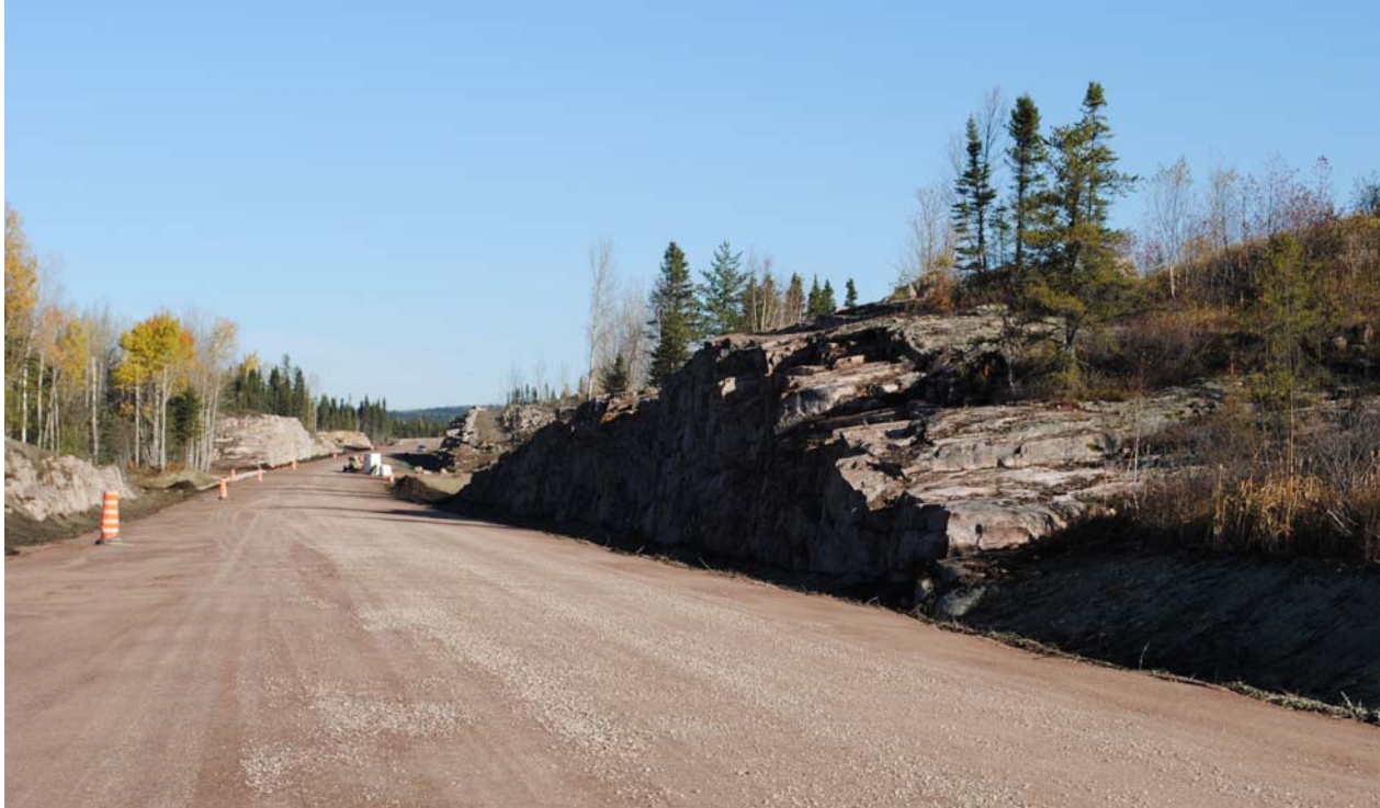
Début du prolongement de l'avenue du Labrador. Les travaux se poursuivent sur 1,1 km.
