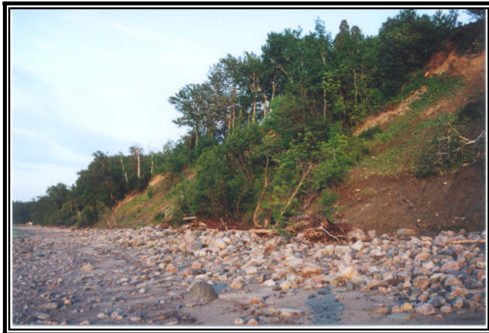
PHOTO 13 : Visée vers l'est de l'accumulation de cailloux et de blocs à la base du talus.
