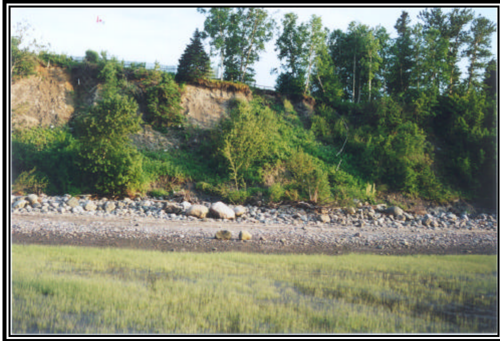
PHOTO 14 : Visée vers le sud montrant l'amoncellement typique de cailloux et de blocs à la base du talus.
