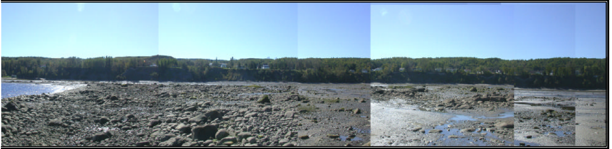
PHOTO # 1 : Vue d'ensemble du secteur à l'étude. On observe à l'avant-plan l'estran, lequel s'avance dans la baie des HA ! HA ! et à l'arrière-plan la pente investiguée adjacente aux propriétés du chemin de la Batture (visée sud).
