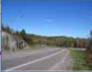
SITUATION DE L'AUTOROUTE 5 ET DE LA ROUTE 105 DANS LA RÉGION DE L'OUTAOUAIS
