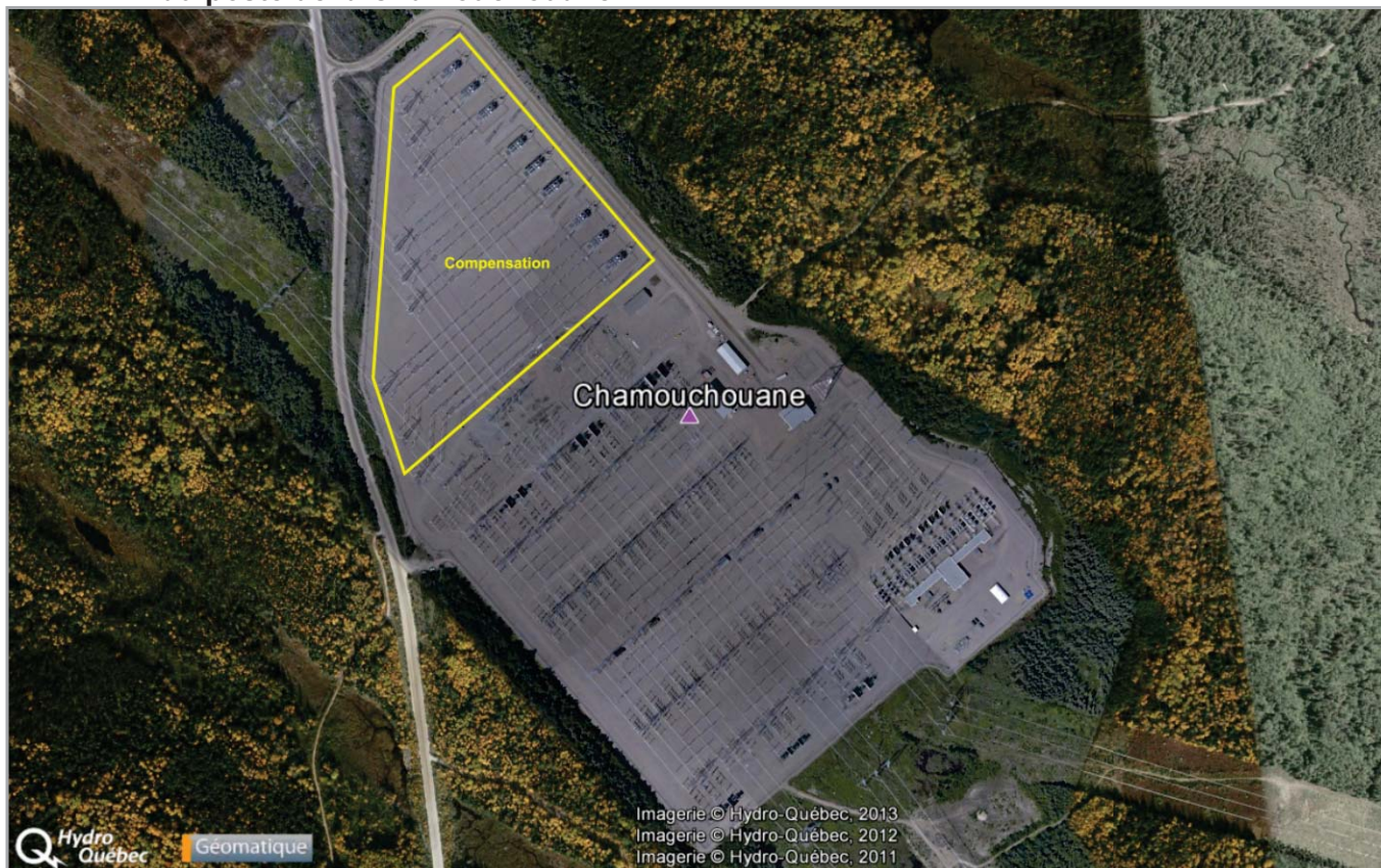
Figure 11 Photographie aérienne de la compensation série existante au poste de la Chamouchouane
