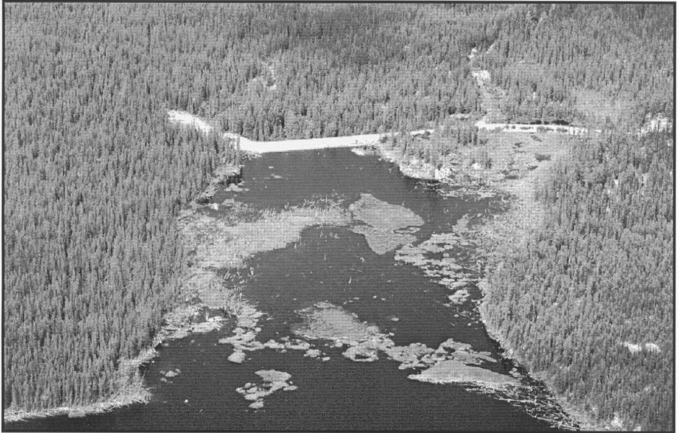
Figure 7 La digue actuelle au nord-est du réservoir du Sault aux Cochons et la simulation du canal de dérivation projeté
