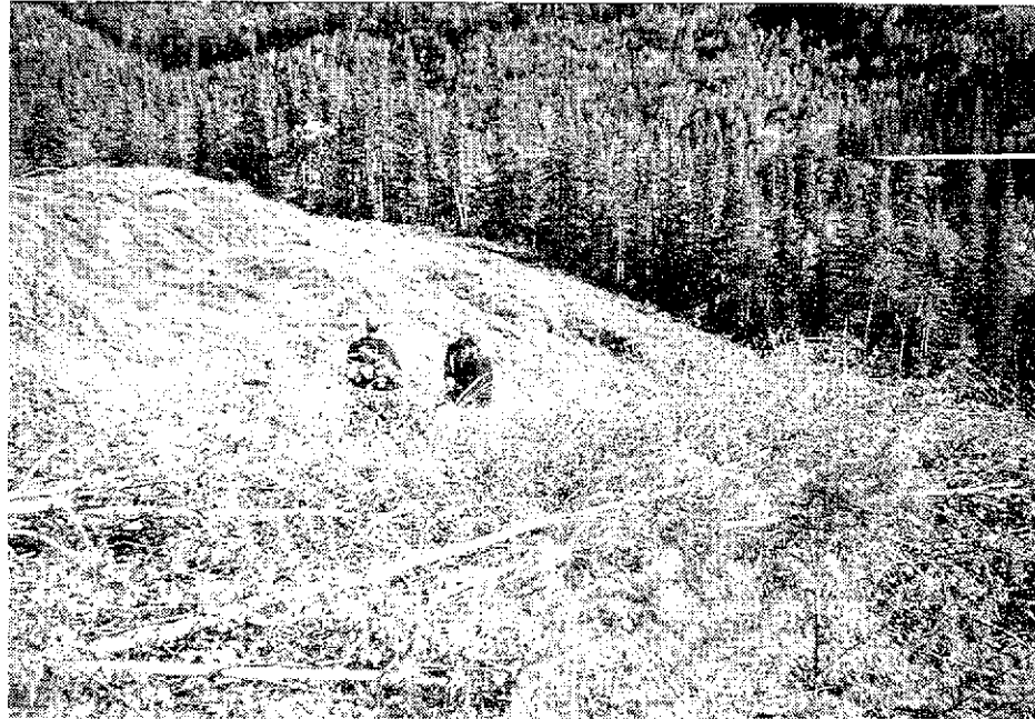
Figure 2.1 Emprise déboisée à la scie mécanique
