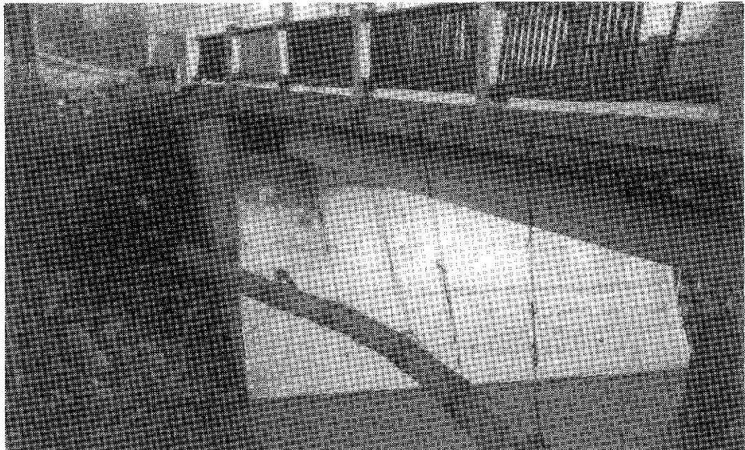
Bien que la structure soit faible au niveau de la flexion, au quart de la portée, selon le rapport d'inspection du MTQ, les culées et la dalle sont en bon état. Dans l'ensemble, le MTQ considère que ce sont des désordres mineurs et que le pont est en mesure de supporter les charges requises. Le rapport recommande également que le pont soit inspecté à chaque année en attendant sa réfection. (Document déposé B-29)
