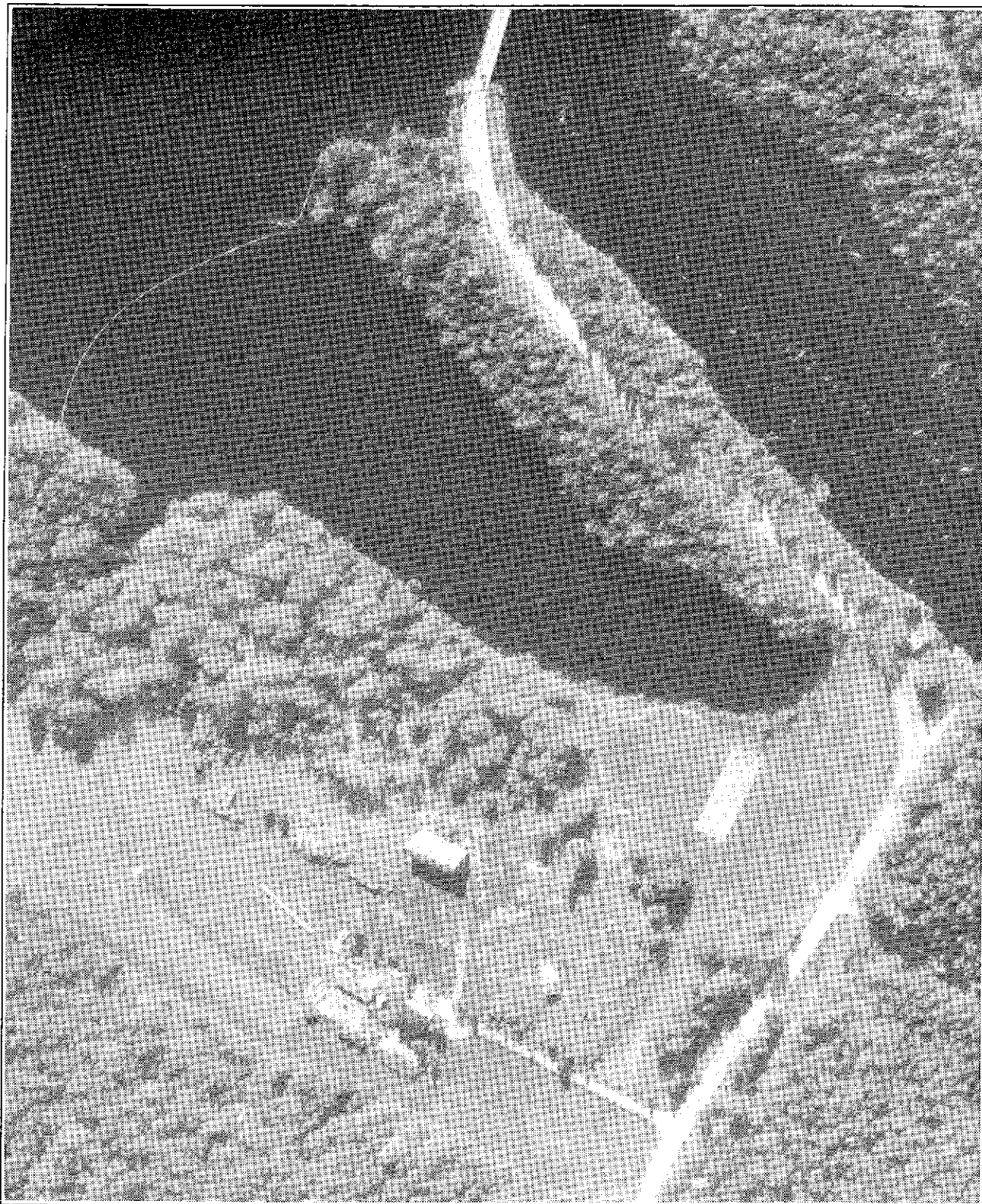
Photo 1 Vue aérienne du site
