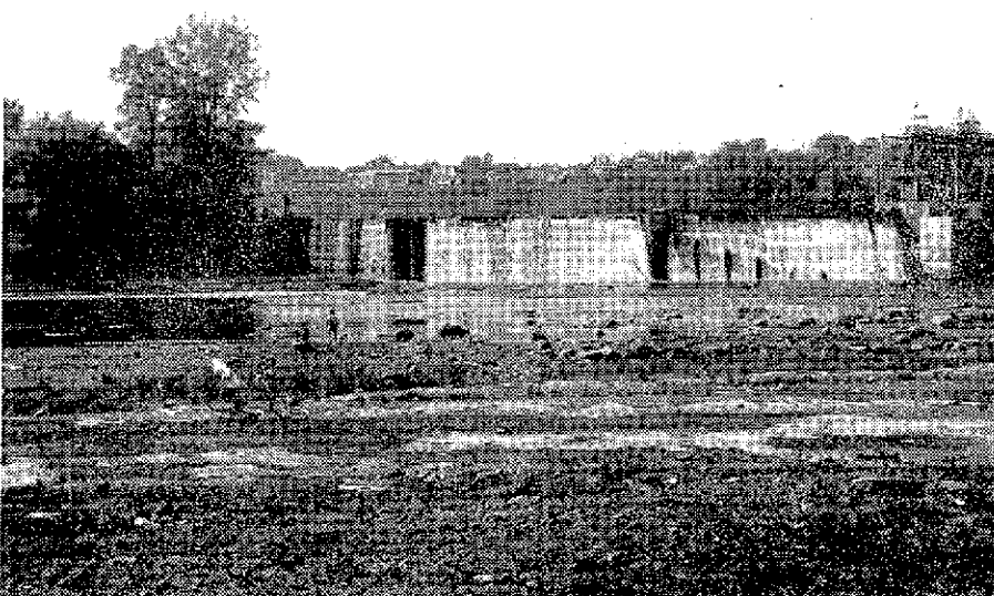
la crête déversante
