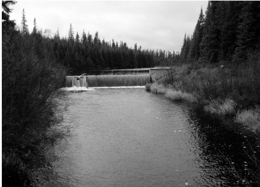
Barrage du marais Vaudray
