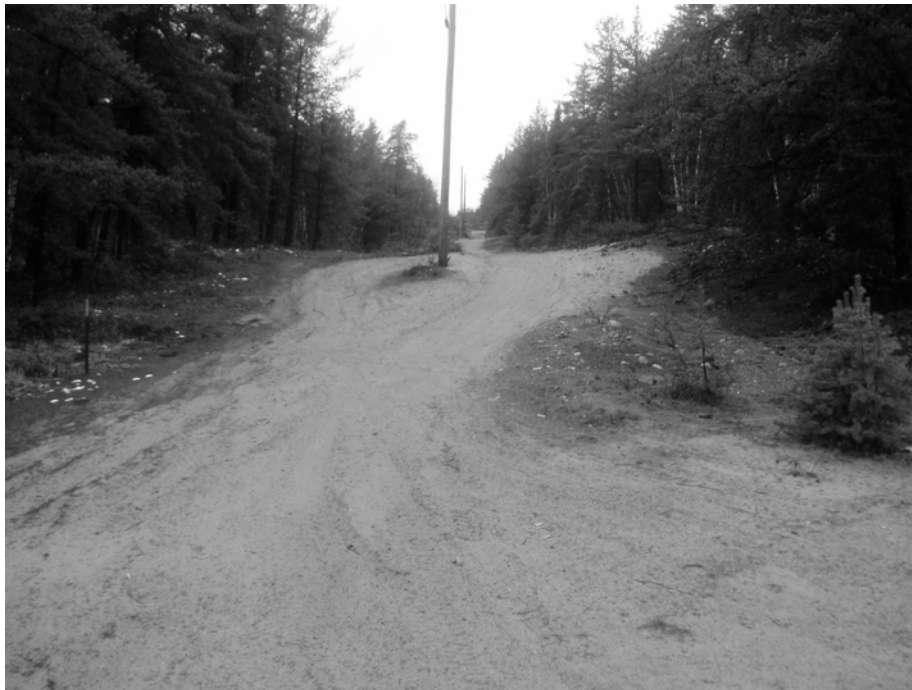
Emprise de la ligne électrique
