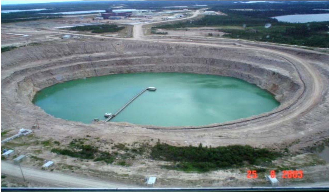
Installation de gestion des résidus en fosse de McClean Lake
