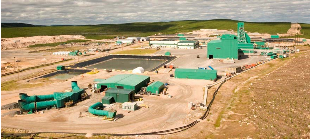
Figure 4-1 : Établissement de McArthur River – Source : Cameco
