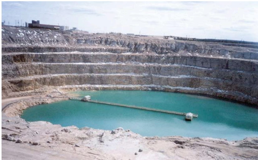
Figure 6.3 (b) — Installation de gestion des résidus de la mine JEB à McClean Lake
