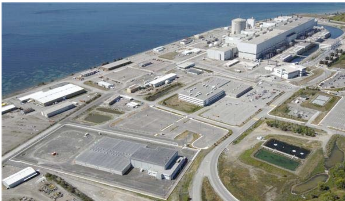
Figure 4.6 — Site de la centrale de Darlington avec l'installation de gestion des déchets à l'avant-plan
