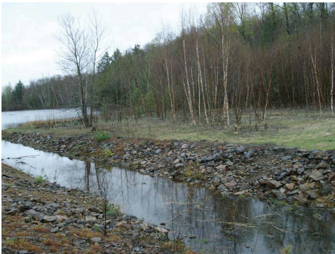
Figure 8.8 — Déversoir du bassin de résidus sud de l'installation de stockage de résidus de Bicroft
