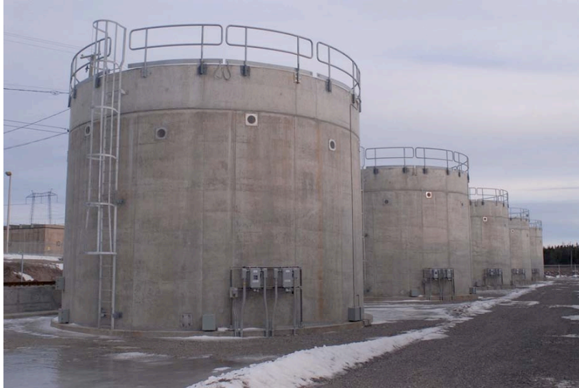
Figure 5.4 — Silos de déchets de retubage de Point Lepreau
