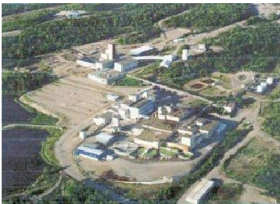
Figure 8.6 (a) — Vue aérienne du site minier de Stanleigh avant le déclassement
