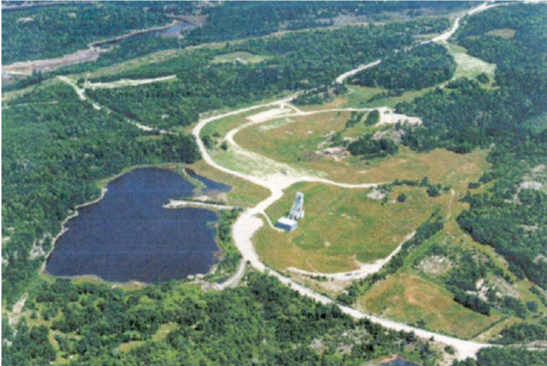
Figure 8.6 (b) — Vue aérienne du site minier de Stanleigh après le déclassement
