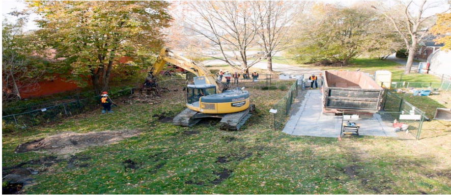
Figure K.5 — Essai d’assainissement à Port Hope
