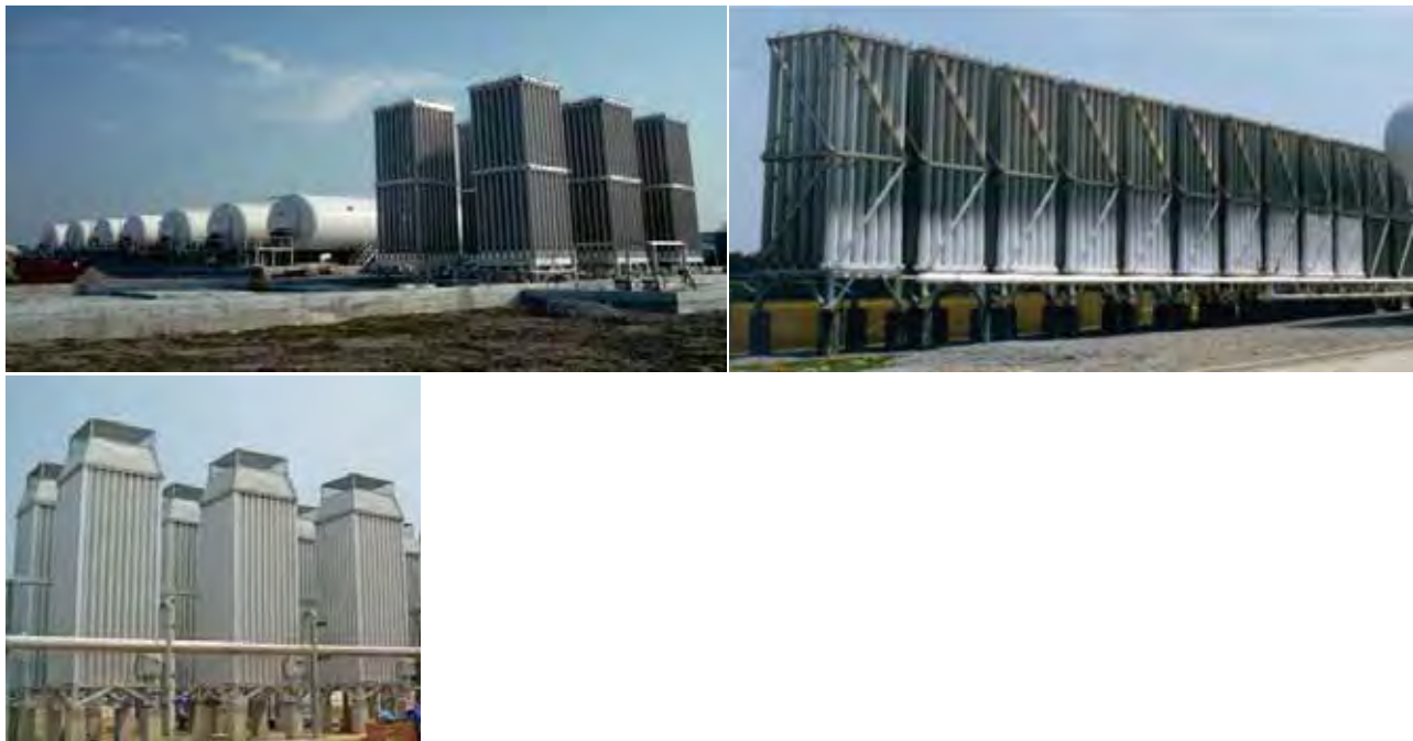
Figure 2.9 Vaporisateurs à convection naturelle et forcée
