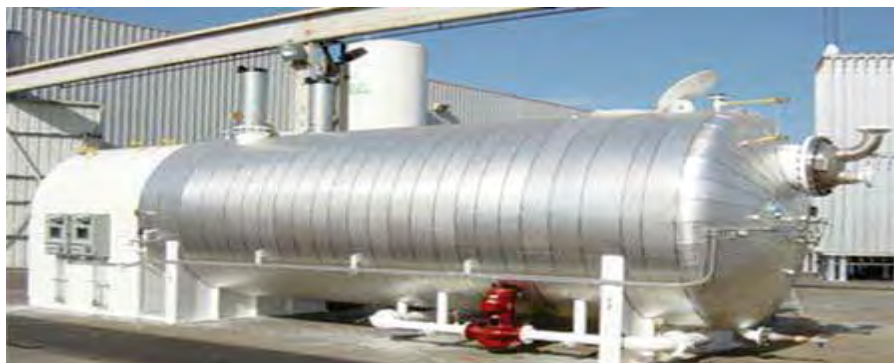
Figure 2.11 Vaporisateur avec bain d'eau chauffée (chauffage indirect)
