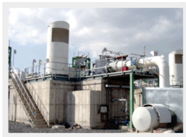
Figure 2.10 Vaporisateur avec bain d'eau chauffée (combustion submergée)
