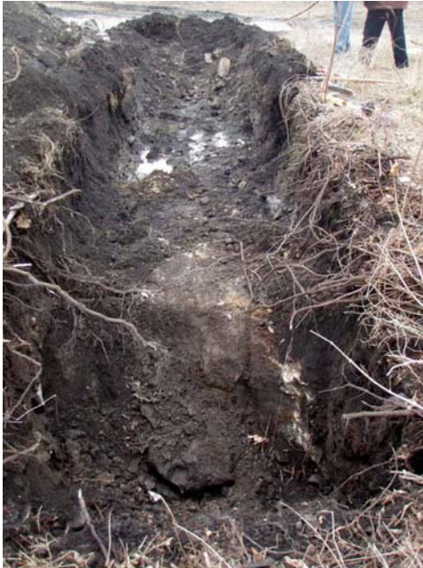
Photo 3: Vue d'ensemble de la tranchée T-8 (HDS1002-10-NUM1-55)
