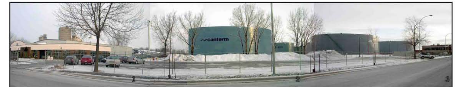
Montage des photos 1 à 3: État prévu du site K-1
