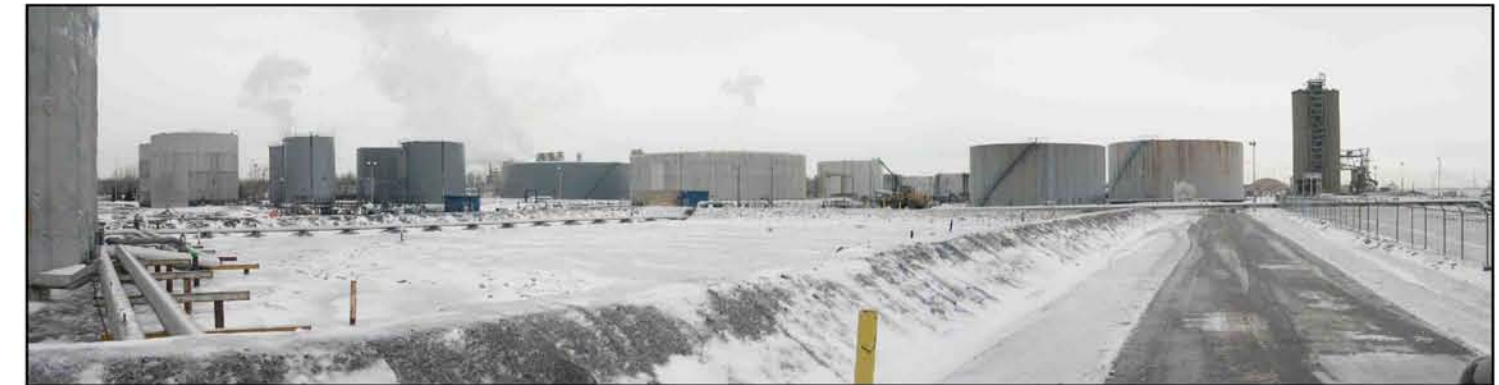
Montage des photos 1 à 3 : État actuel du site K-3 (côté est)
