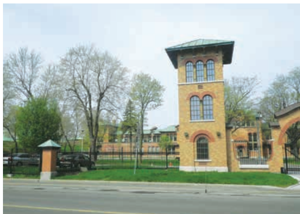
Photo 3 : Vue de l'usine de filtration Atwater
