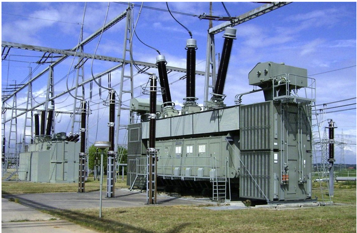
FIGURE 2.1 Transformateur typiquement utilisé dans les stations électriques
