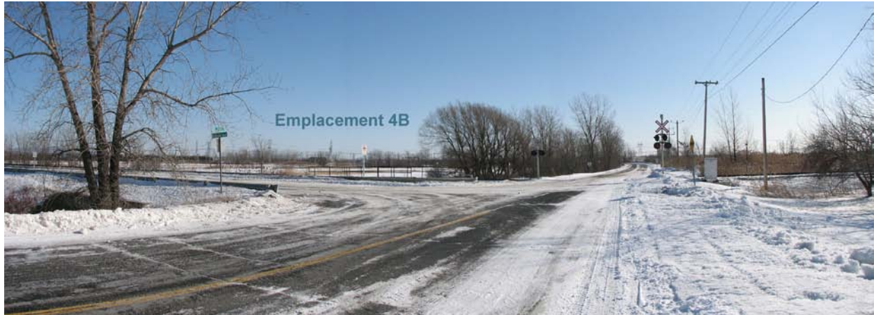
Photo 4-6 : Emplacement 4B vu depuis les résidences du rang Du Canal, à l'extrémité ouest du site
