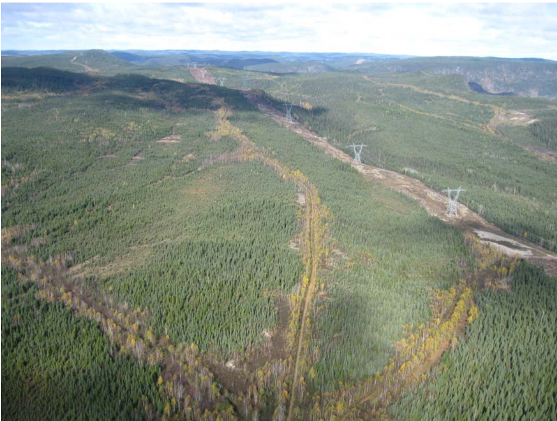
Photo QC-8-1 : Vue d'ensemble de l'emplacement du poste projeté
