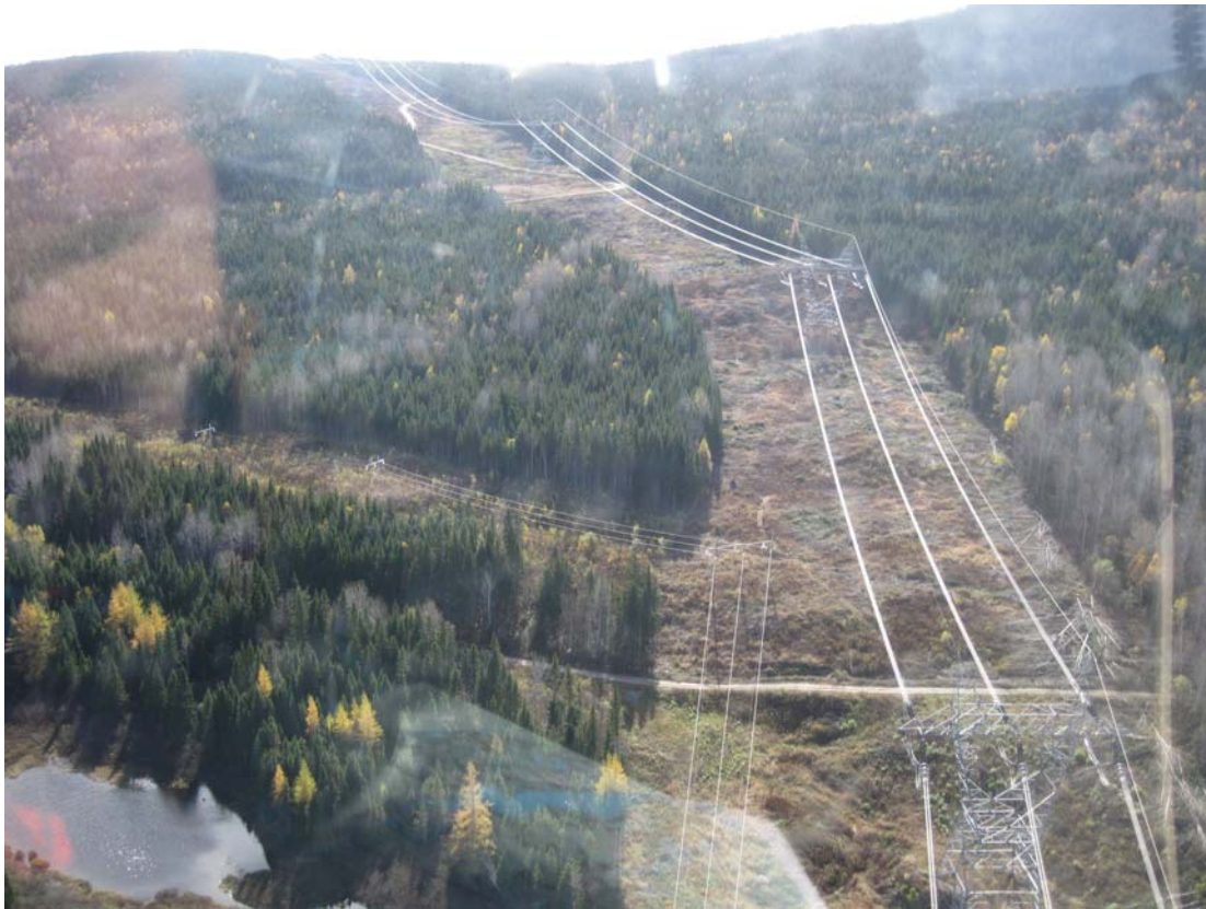
Photo QC-8-6 : Vue aérienne de l'emprise existante à proximité du poste Micoua (vue vers le sud à partir du poste Micoua)
