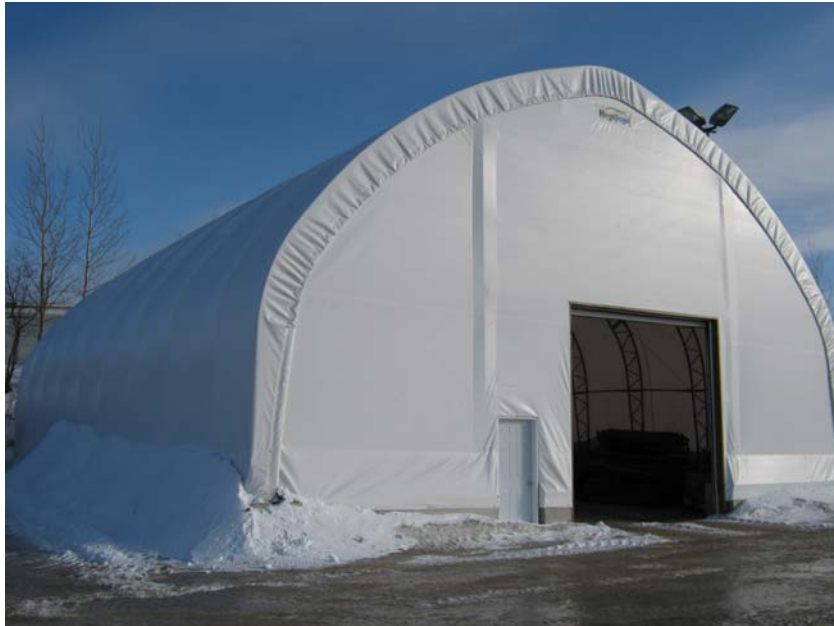
Photo 1-1 : Bâtiment de type MegaDome
