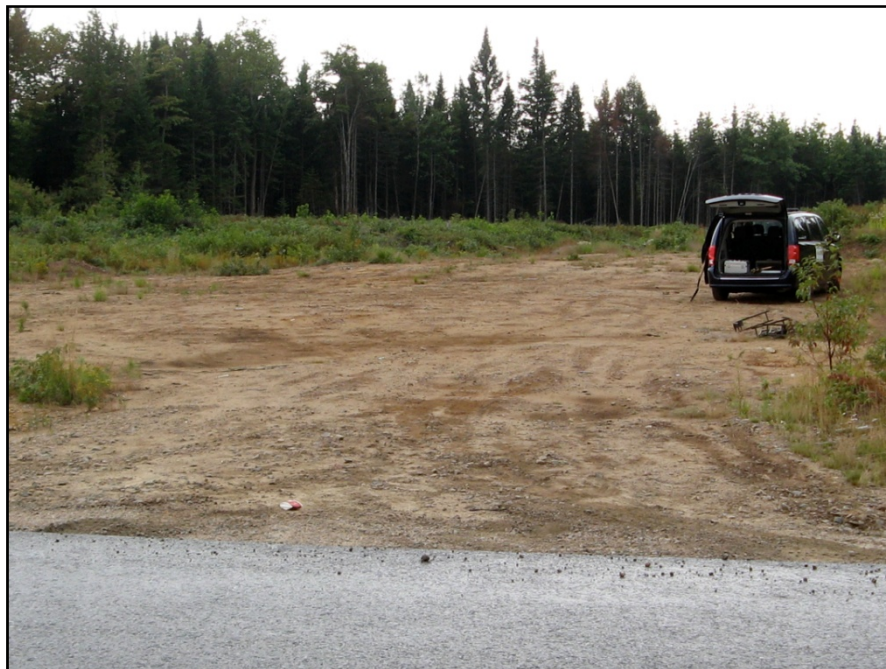
Photo 4 : Vue générale de la section déboisée de la zone P8. Vue en direction ouest (HYD1215-12-NUM1-1)
