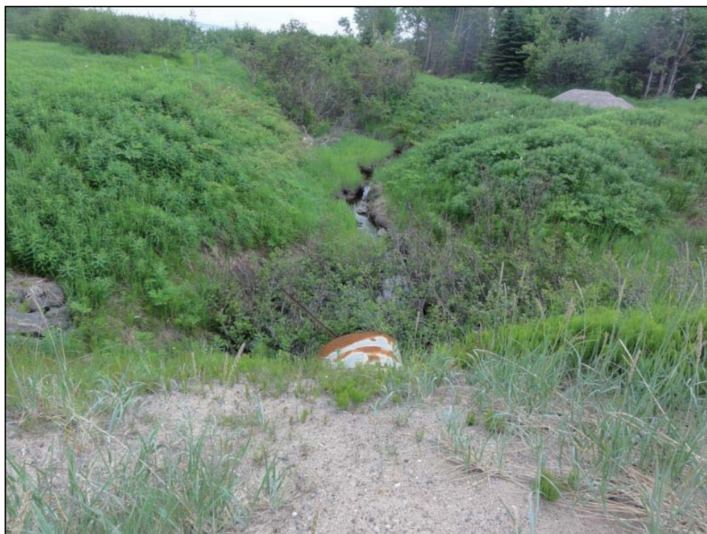
Photo 4 Ruisseau R5 - Extrémité amont du ponceau de la route 138 (19 juin 2012).
