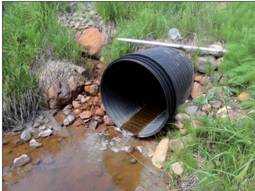
Photo 12 Ruisseau 81 - Extrémité aval du ponceau de la route 138 (20 juin 2012).
