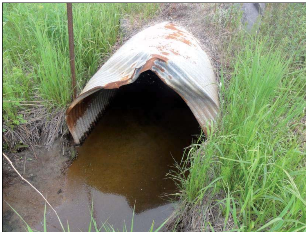
Photo 6 Ruisseau R7 - Extrémité aval du ponceau de la route 138 (19 juin 2012) (effet de refoulement d'un ponceau aval).
