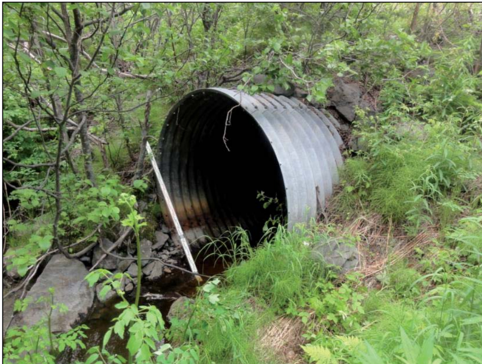
Photo 13 Ruisseau R10 - Extrémité aval du ponceau de la route 138 (20 juin 2012).
