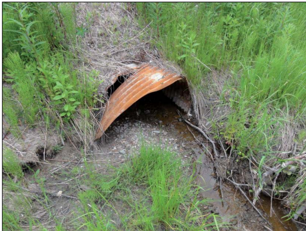
Photo 3 Ruisseau R4 - Extrémité aval du ponceau de la route 138 (19 juin 2012).
