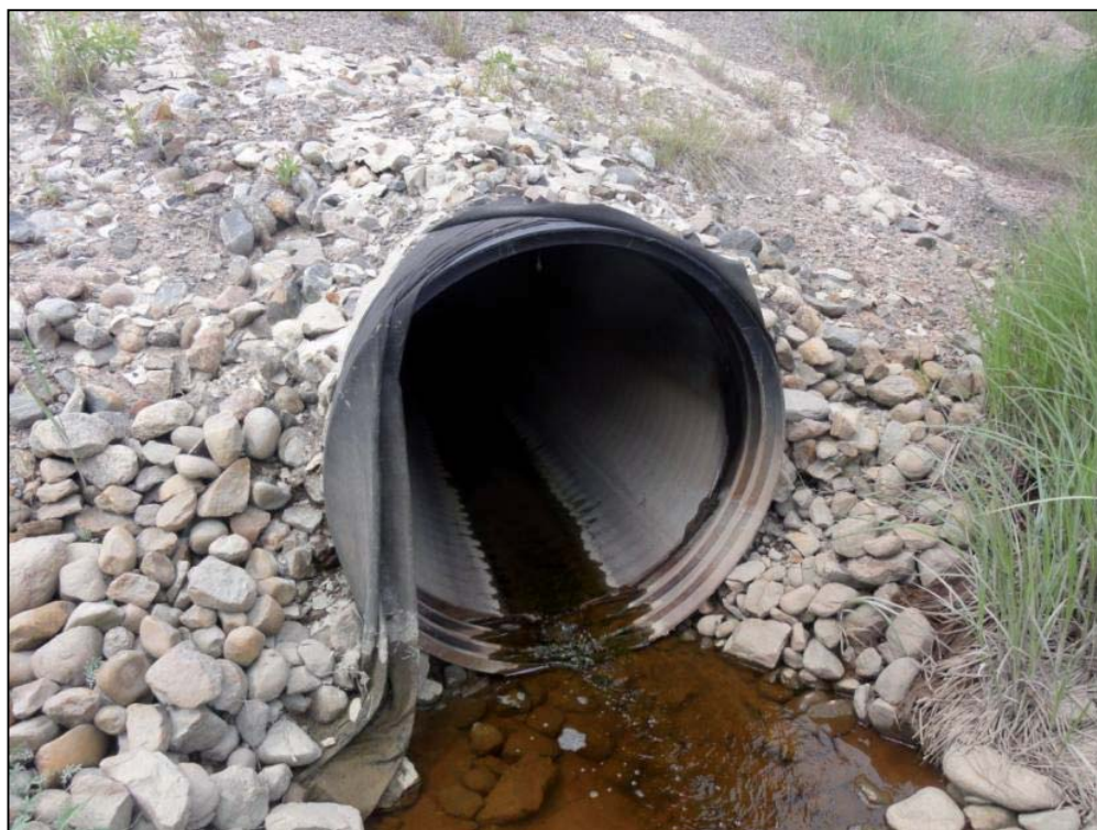
Photo 8 Ruisseau R9.5 - Extrémité aval du ponceau de la route 138 (19 juin 2012).
