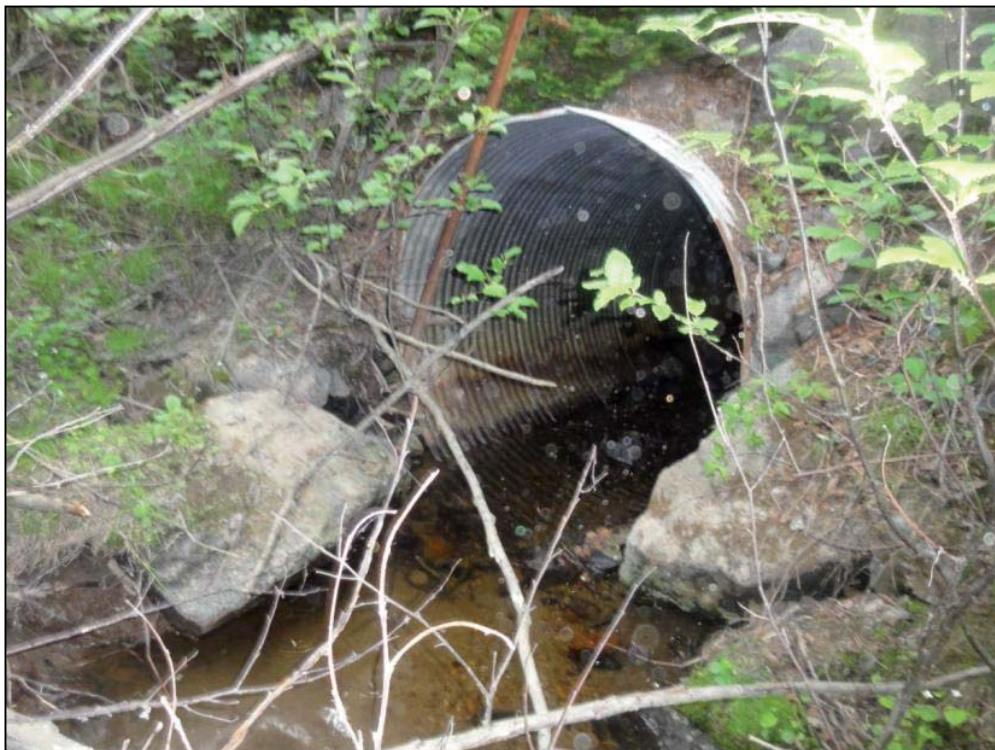
Photo 1 Ruisseau R2 - Extrémité amont du ponceau de la route 138 (19 juin 2012).
