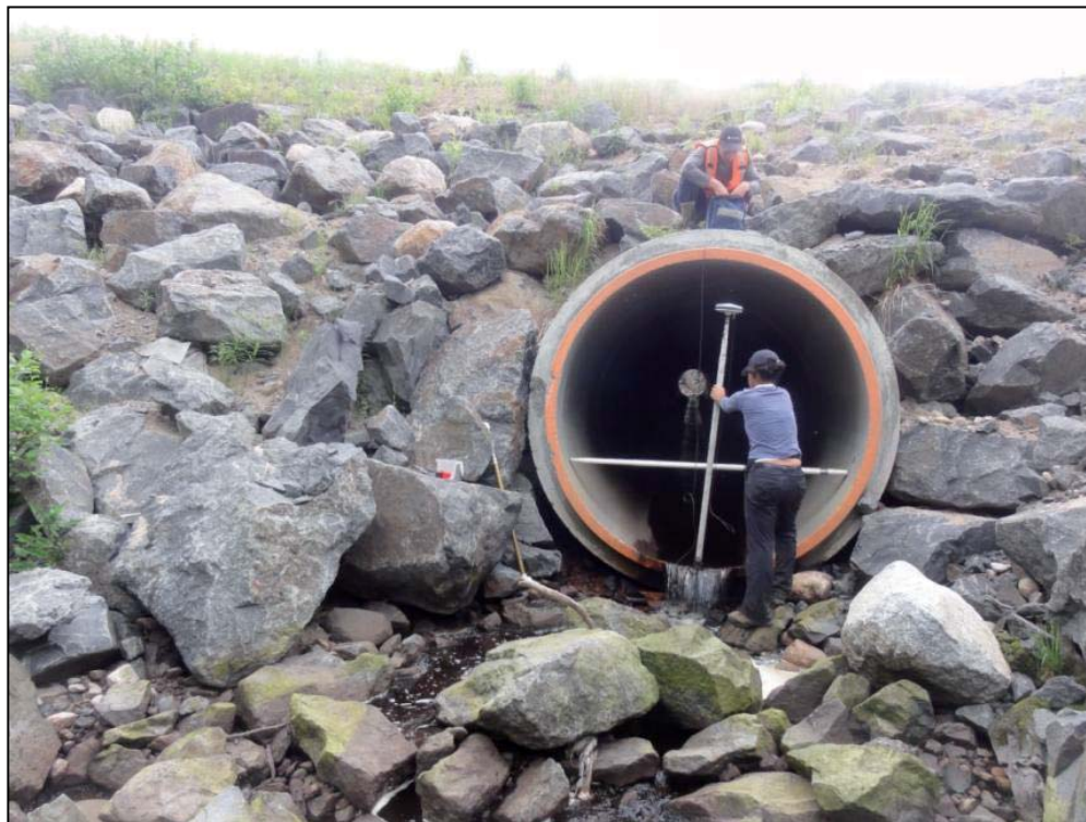
Photo 15 Ruisseau R11 - Extrémité aval du ponceau de la route 138 (20 juin 2012).
