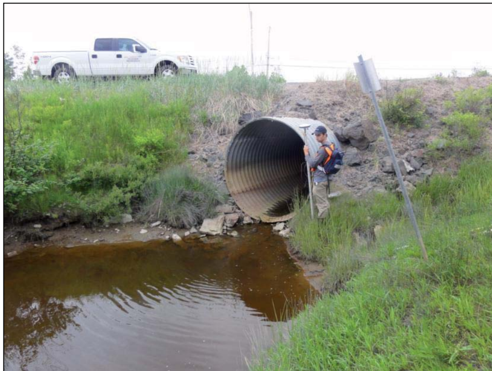
Photo 7 Ruisseau R8 - Extrémité aval du ponceau de la route 138 (19 juin 2012).
