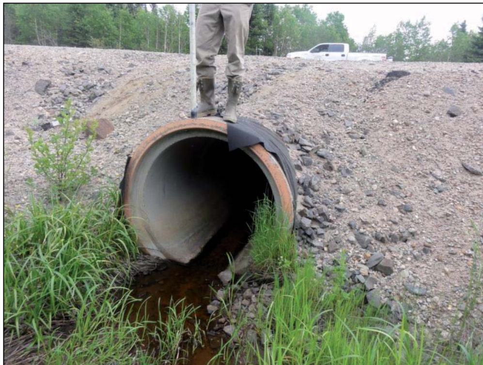
Photo 5 Ruisseau R6 - Extrémité aval du ponceau de la route 138 (19 juin 2012).
