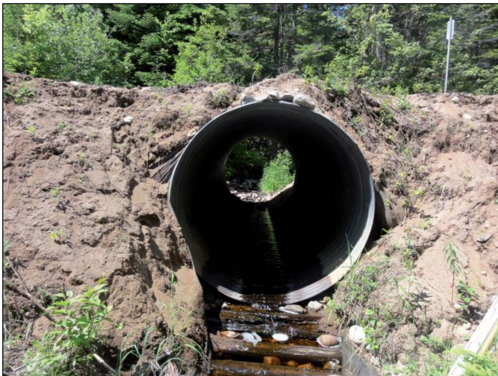
Photo 14 Ruisseau R10 - Extrémité aval du ponceau de la route du chemin du Vieux Sept-Îles (20 juin 2012).
