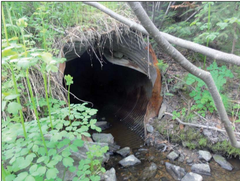
Photo 2 Ruisseau R3 - Extrémité aval du ponceau de la route 138 (19 juin 2012).
