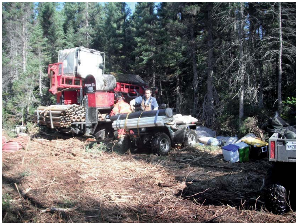
Photo 2 Équipements d'installation de puits, secteur parc à résidus.
