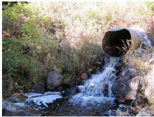
Photo 16 Ponceau de la voie ferrée au ruisseau R10 (octobre 2010)
