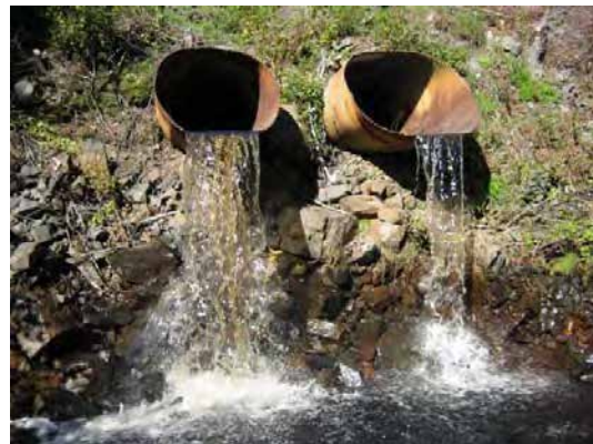
Photo 12 Ponceau de la voie ferrée au ruisseau Clet (octobre 2010)
