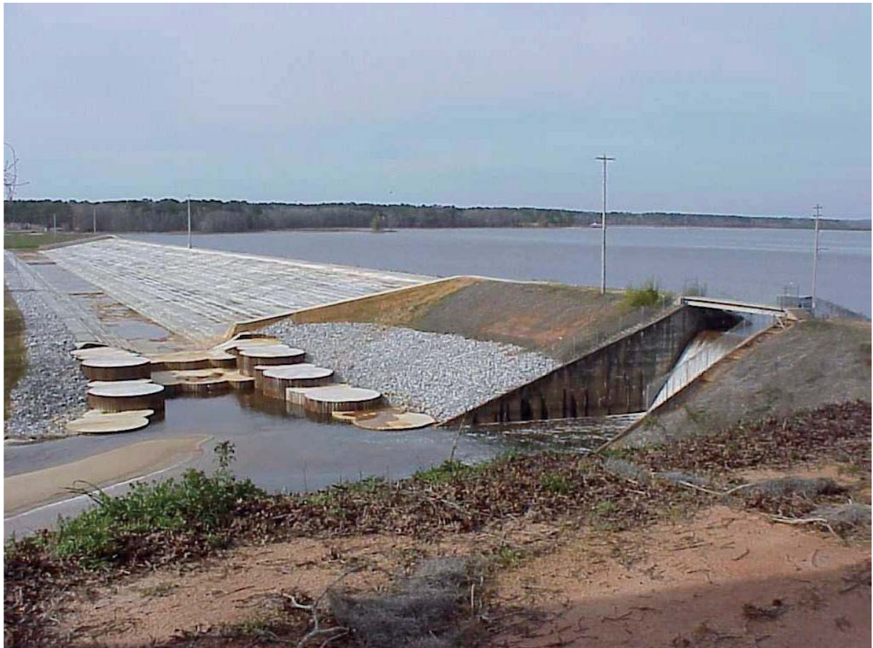
Figure 4.1 - Exemple de digue à crête déversante
