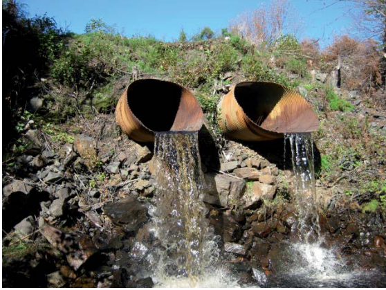
Photo 9.10.1 Ponceaux sur le ruisseau Clet
