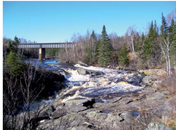
Photo 9.10.4 Pont ferroviaire au-dessus de la rivière des Rapides
