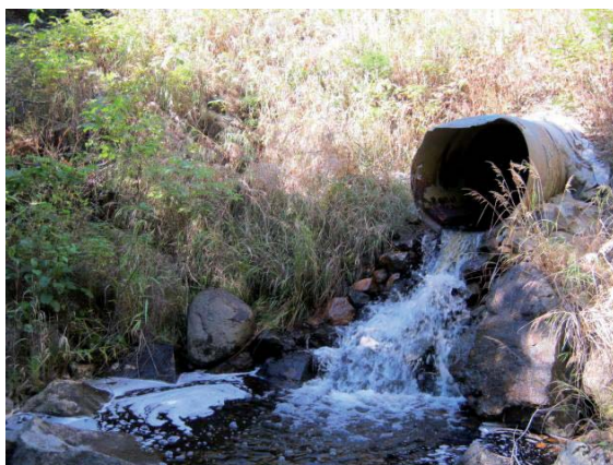
Photo 10.1.6 Ponceaux sous la voie ferrée du ruisseau R10 à démanteler (octobre 2010)
