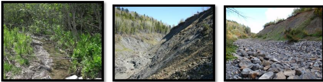
Figure 1 : Exemple d'impact morphologique d'une modification du régime hydrologique et des mesures de restauration nécessaires (ruisseau du Bonhomme-Morency, où la superficie du bassin versant a triplé).
