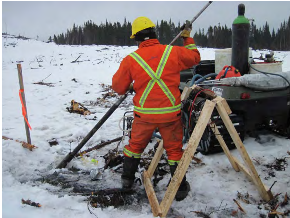
Photo 5 Insertion des obturateurs dans le puits G2012-05, en date du 12 mars 2012.
