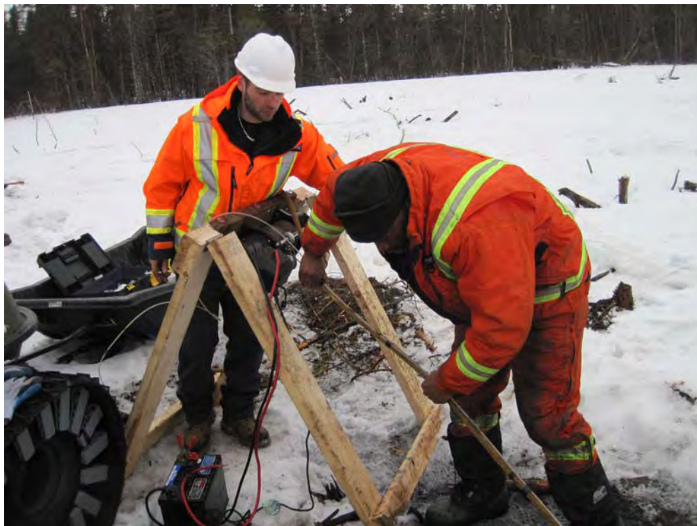
Photo 8 Descente des obturateurs au moyen d'un câble d'acier, en date du 12 mars 2012.
