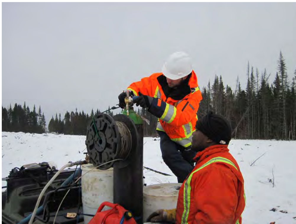
Photo 6 Gonflement des obturateurs au moyen d'une bonbonne d'azote, en date du 12 mars 2012.
