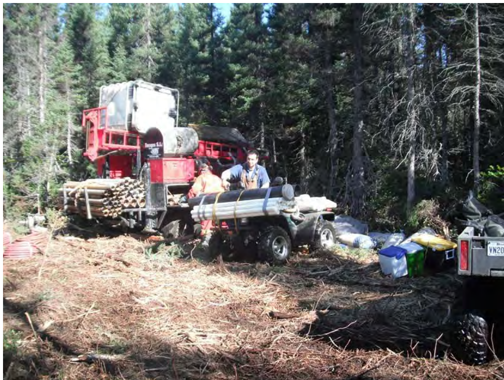
Photo 2 Équipements d'installation de puits, secteur des parc à résidus.
