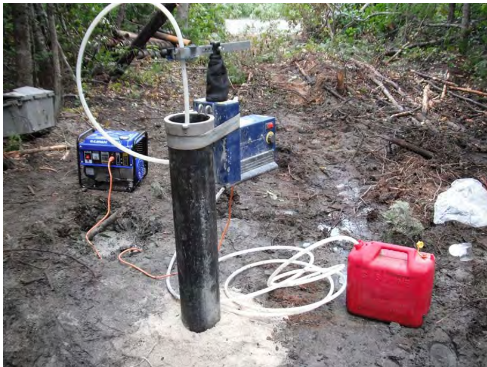
Photo 6 Développement du puits PO-1R, secteur sud de la fosse.
