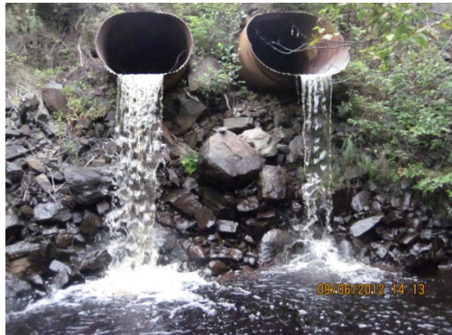
Photo 4-3 Ponceau sous la voie ferrée Ruisseau Clet
