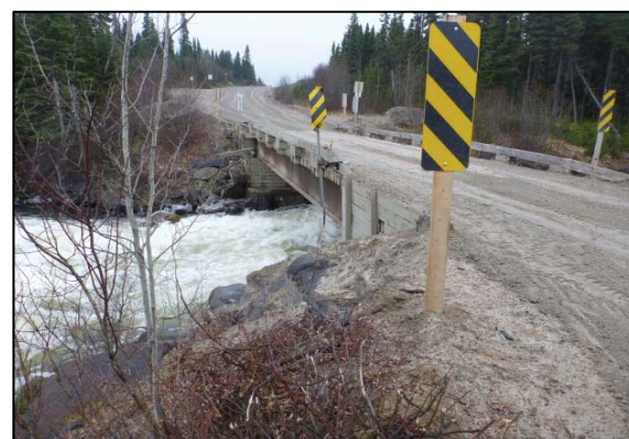
Photo 3 : Pont, vue vers le nord
