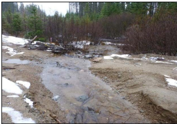
Photo 1 : Segment 4 (seuil), vue vers l'aval (aucun pontceau)
