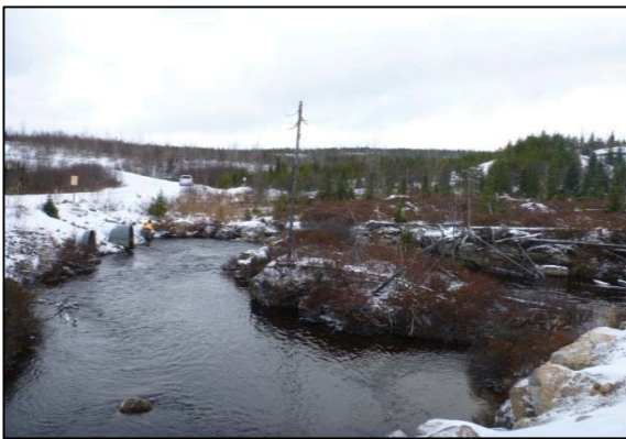
Photo 1 : Segment 7 (seuil) en aval du chemin principal, vue vers l'amont
