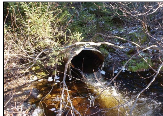
Photo 3 : Ouverture aval du ponceau (franchissable)
