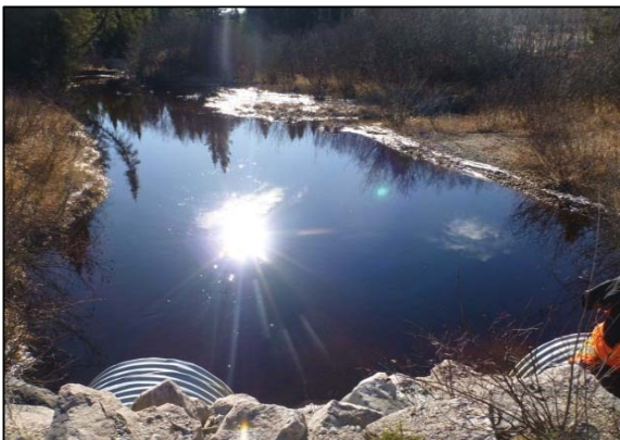
Photo 1 : Segment 4 (bassin), vue vers l'aval
