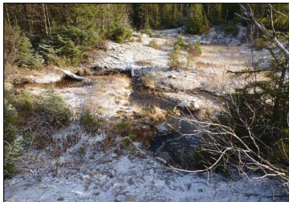
Photo 1 : Segment 2 (seuil), vue vers l'aval
