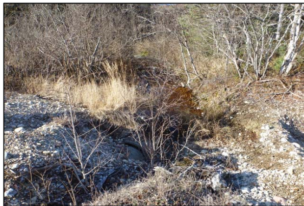
Photo 1 : Segment 1 (seuil), vue vers l'aval
