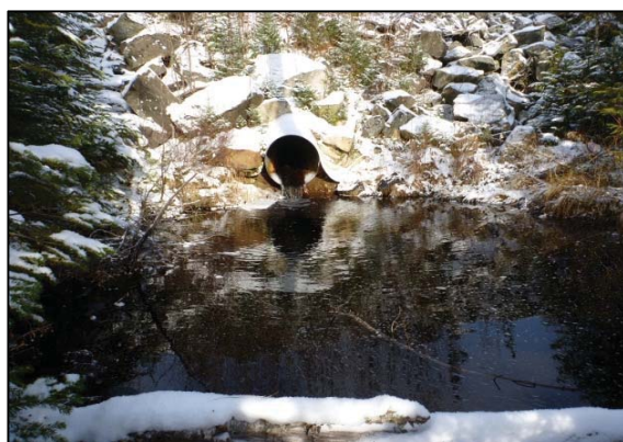
Photo 1 : Segment 7 (bassin) et ponceau (OBS5), vue vers l'amont
