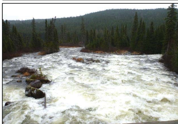
Photo 1 : Segment 1 (rapide) du pont, vue vers l'aval
