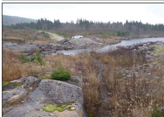
Photo 1 : Segment 1, vue de la rive droite vers l'aval (ponceau inexistant)
