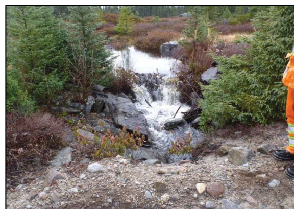
Photo 2 : Segment 4 (bassin) et écluse à castor (OBS27), vue vers l'amont
