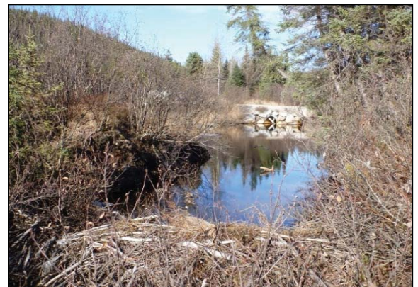
Photo 3 : Segment 4 écluse (OBS48) et bassin, vue vers l'amont
