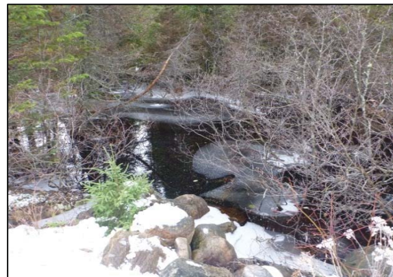
Photo 2 : Segment 2a (bassin), vue vers l'amont
