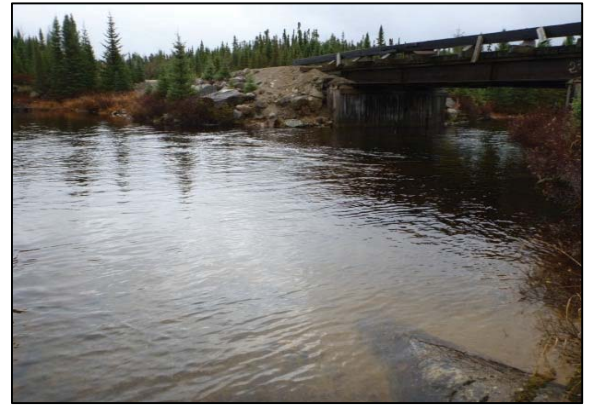
Photo 3 : Segment 2 (seuil sous le pont), vue en amont de la rive gauche
