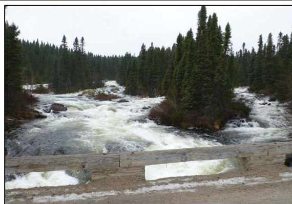
Photo 2 : Segment 2 (rapide-cascade) du pont, vue vers l'amont
