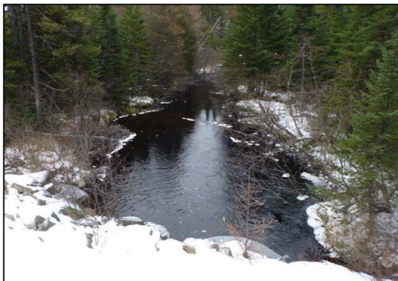
Photo 1 : Segments 6 et 7 (seuil et bassin), vue vers l'aval
