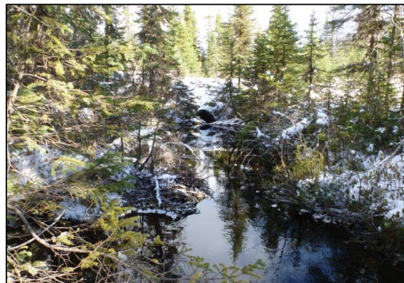
Photo 2 : Segment 3 (bassin-écluse), vue vers l'aval
