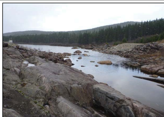
Photo 2 : Segment 1, vue de la rive gauche vers l'aval
