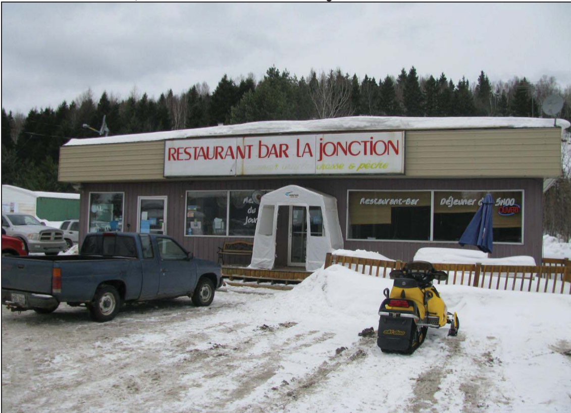
Photo 4-25 : Restaurant, station-service et relais de motoneige « La Jonction »
