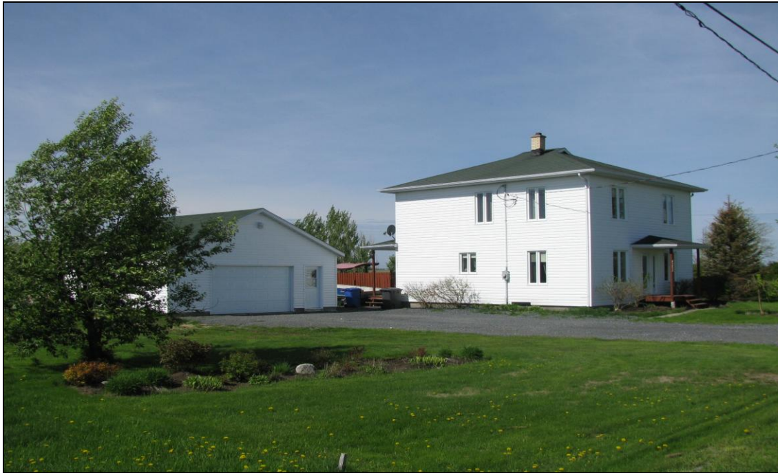
Photo 4-3 : Résidence privée d'une ferme du rang Saint-Louis localisée à 20 m à l'est de la variante A
