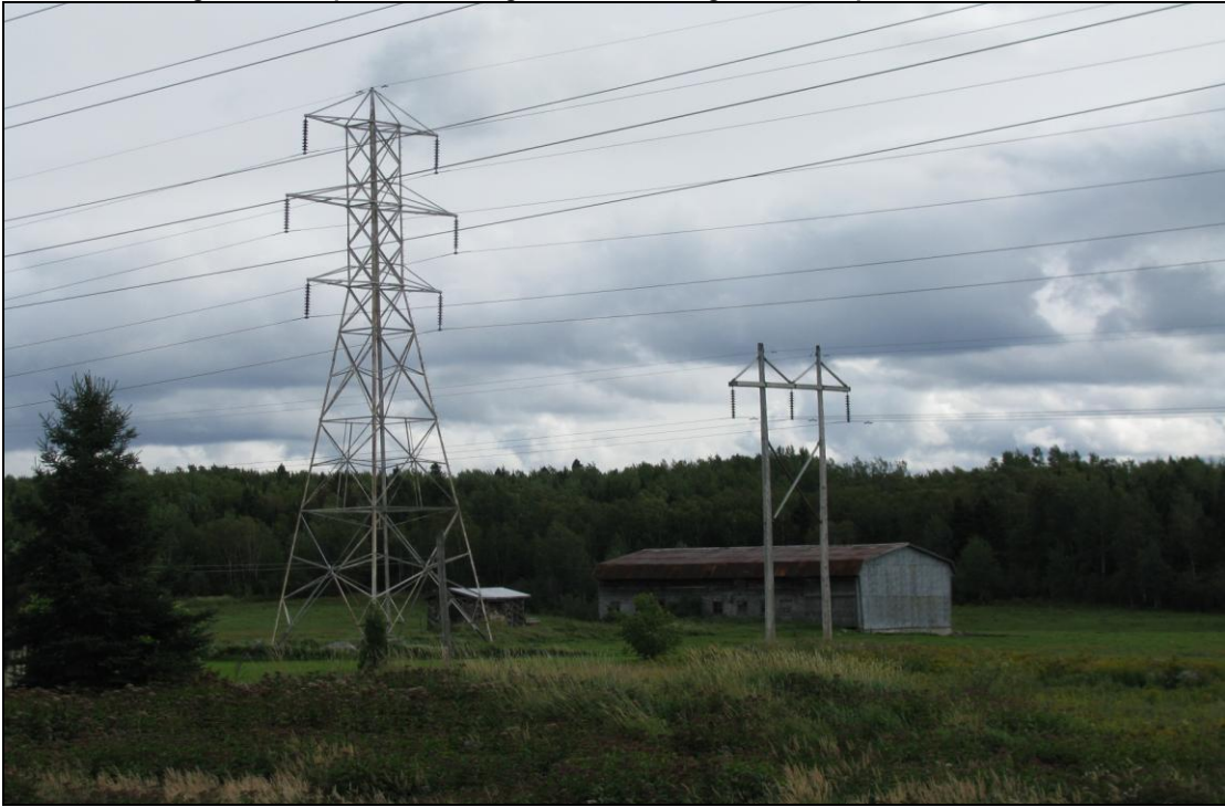
Photo 4-10 : Lignes électriques et terres agricoles du 3 e rang traversées par la variante C1
