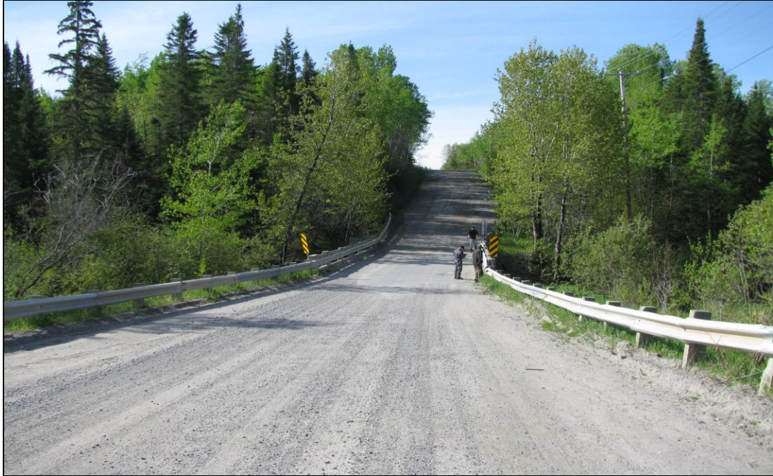
Photo 4-5 : Pont de la rivière Mistouk sur le chemin de la Grande-Ligne, vue vers le sud
