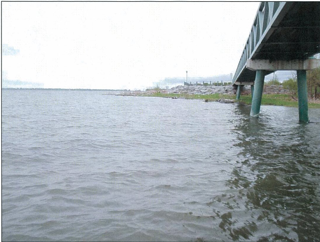
Vue générale du secteur ouest (vue vers l'est), le 17 mai 2007
