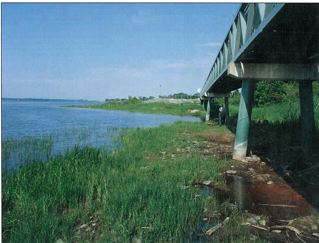
Vue générale du secteur ouest (vue vers l'est), le 12 juin 2007
