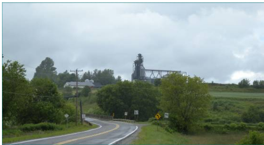
Ensemble industriel de transbordement lié au chemin de fer
