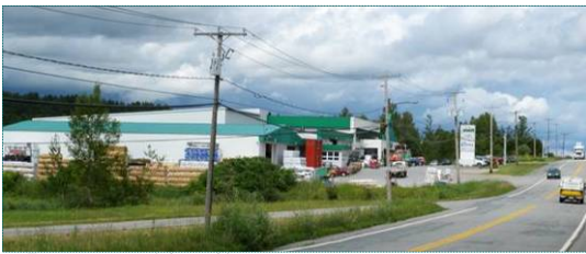
Zone commerciale mal intégrée
