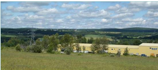
Parc industriel et ligne hydroélectrique
