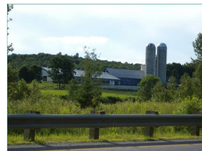
Vue des fermes et silos de l'autoroute 55
