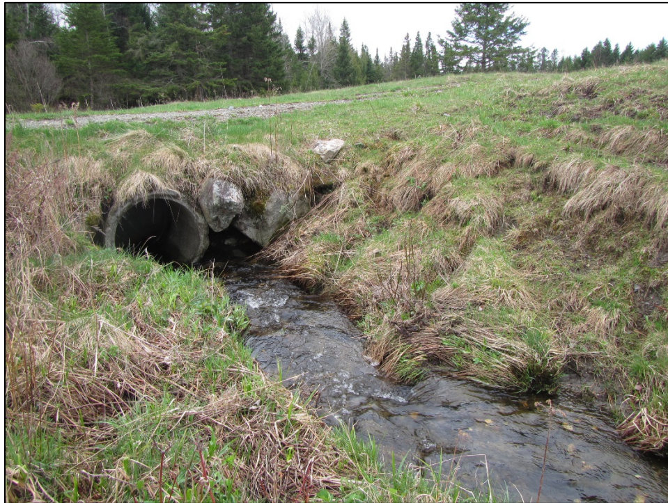
Photo 1 Amont du ponceau de la traversée 1319MB.
