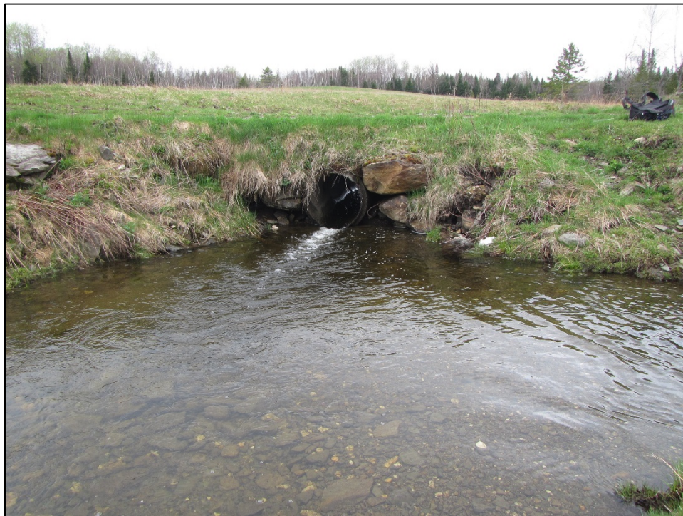
Photo 2 Frayère potentielle de qualité faible à l'aval du ponceau de la traversée 1319MB.
