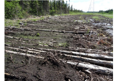
Photo A.17 : Réaménagement d'un sentier sur fascines avec de la terre végétale et encensement, projet de la ligne Figuery-Palmarolle
