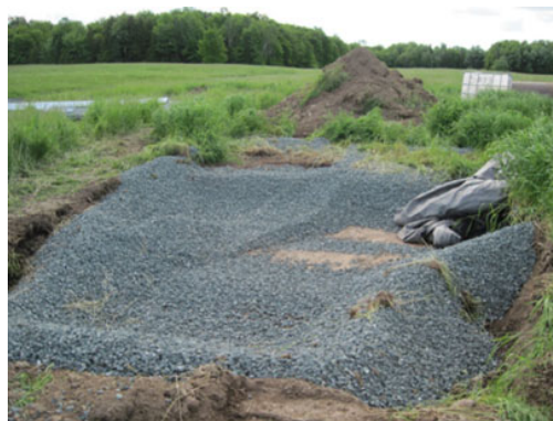
Photo F.1 : Aire d'entreposage de matériau granulaire, projet de la ligne Nicolet-Bécancour
