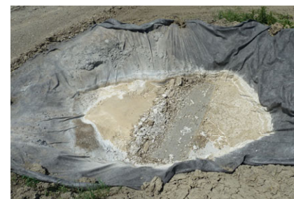
Photo G.3 : Résidus de béton asséchés au fond de la trappe à sédiments, projet de la ligne Nicolet-Bécancour
