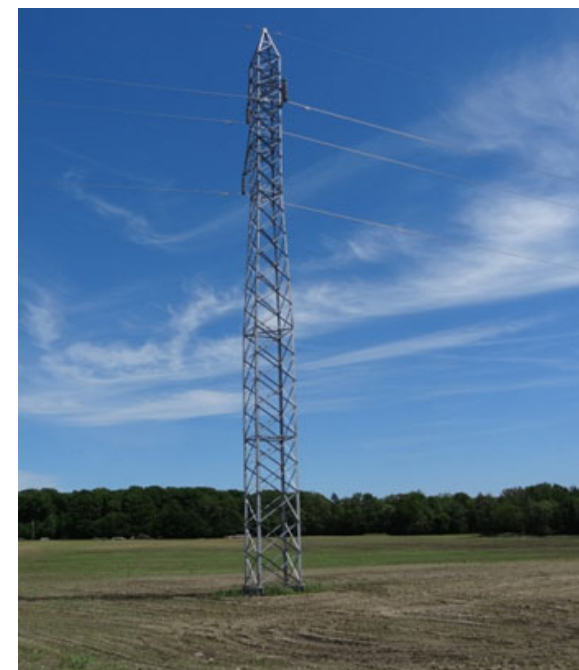
Photo D.5 : Terre agricole remise en état après les travaux
