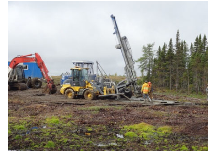
Photo A.12 : Utilisation de plaques d'acier dans une aire de travail, projet de raccordement du complexe de la Romaine
