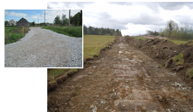
Photo D.1 : Décapage en vue de la construction d'un chemin et mise de côté de la terre arable, projet de la ligne du parc éolien De L'Érables
