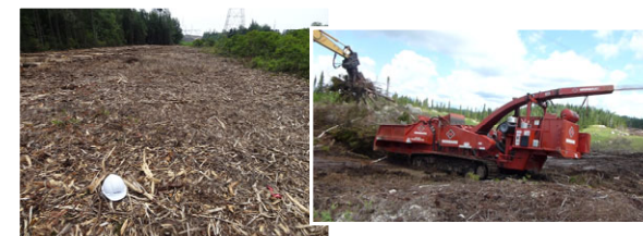
Photo J.1 : Déchiqueteuse en action (projet de raccordement du complexe de la Romaine) et copeaux dispersés sans accumulation (projet de la ligne Nicolet-Bécancour)
