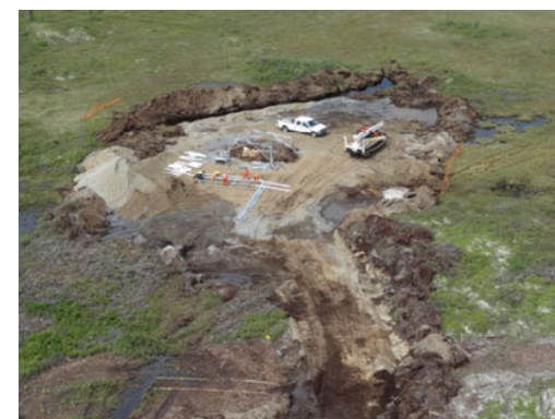
Photo F.2 : Aire de travail pour la construction d'un pylône , projet de raccordement de la centrale de la Courbe-du-Sault
