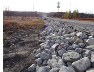
Photo F.7 : Talus de chemin stabilisé par la mise en place d'un enrochement sur une membrane géotextile, projet de raccordement du complexe de la Romaine
