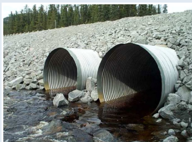
Photo B.2 : Ponceau à tuyaux parallèles
