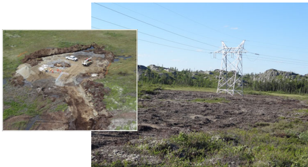
Photo A.15 : Réaménagement d'une aire de travail en milieu humide, projet de raccordement de la centrale de la Courbe-du-Sault
