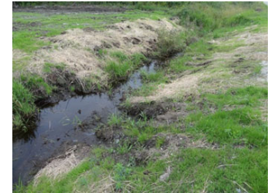
Photo F.4 : Protection des sols par mise en place de paille et ensemencement
