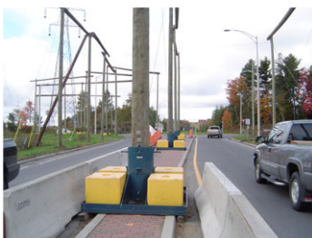
Photo H.1 : Portiques de bois installés pour maintenir la circulation lors du déroulage des conducteurs
