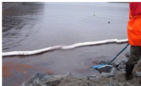
Photo I.3 : Confinement d'un déversement dans un cours d'eau
