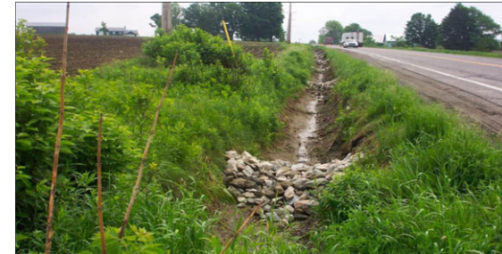
Photo F.8 : Berme en enrochement (source : MTQ, 2014)
