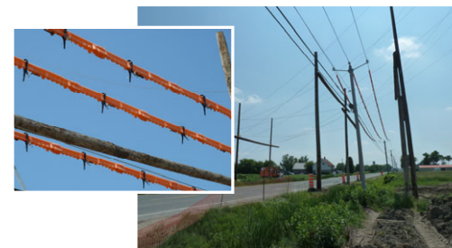
Photo H.5 : Protections aériennes et protecteurs de conducteur utilisés pour le croisement d'une ligne sous tension, projet de la ligne Nicolet-Bécancour
