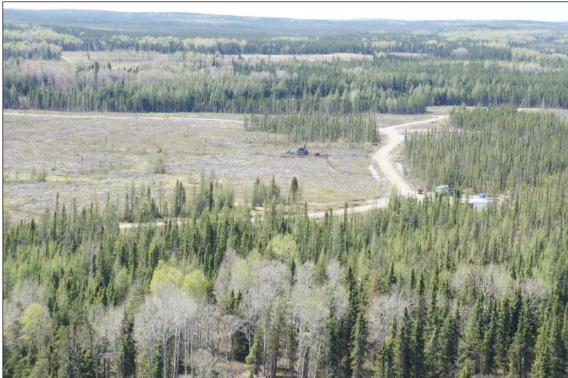
Figure 5.3 : Aperçu de la propriété Dumont : topographie typique non accidentée, unité de forage et coupe à blanc ciblée
