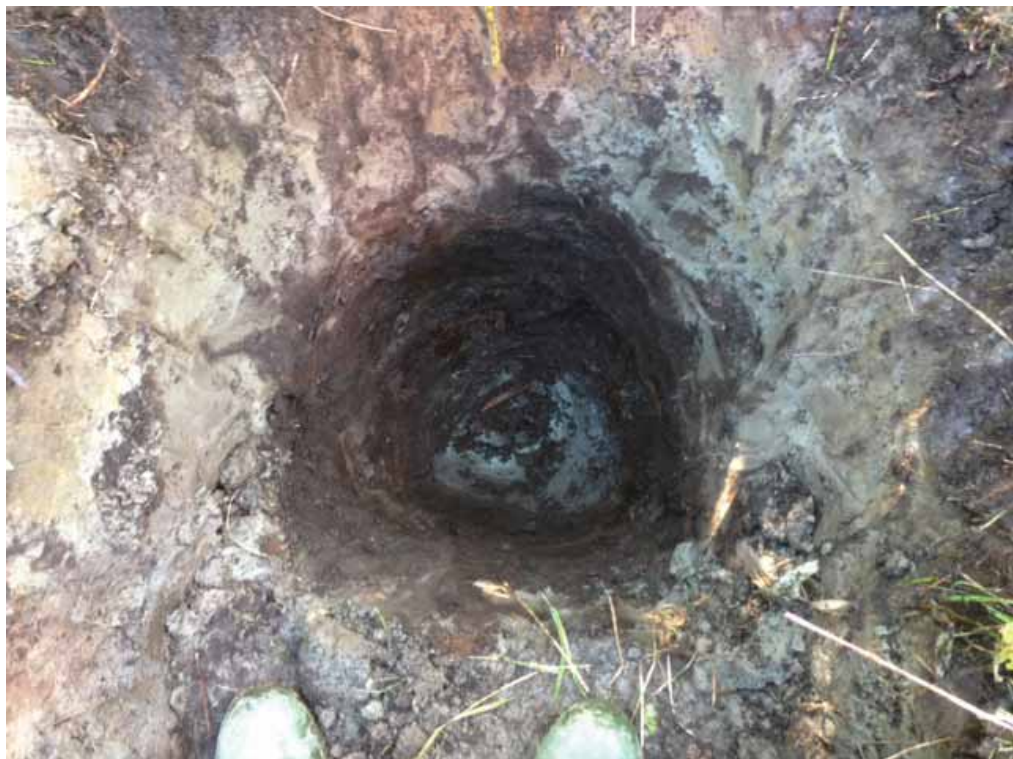
Photo 14 Stratigraphie observée à l'intérieur du sondage SM-4.
