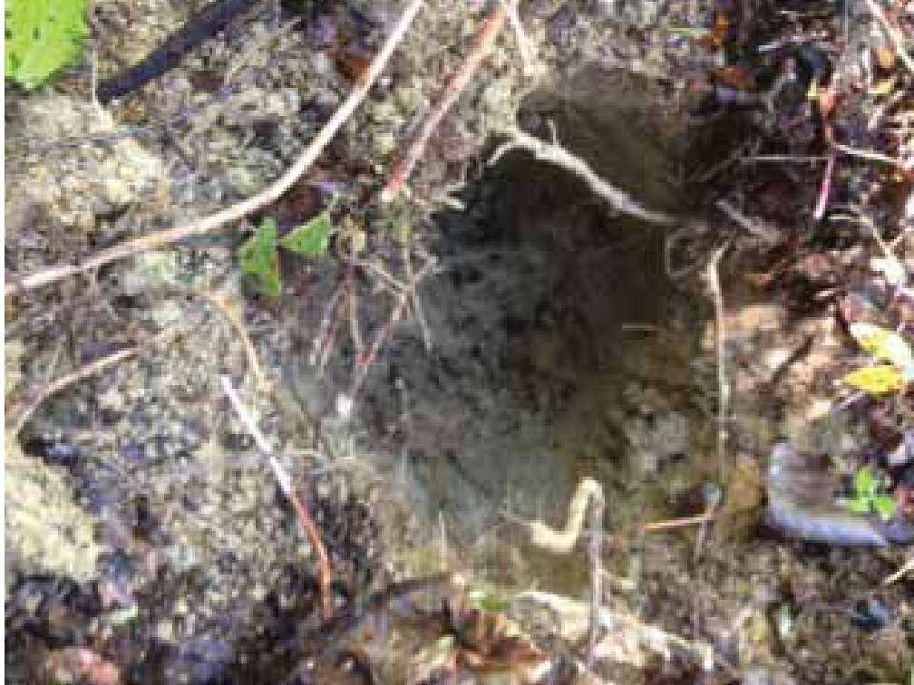
Photo 15 Stratigraphie observée à l'intérieur du sondage SM-5.
