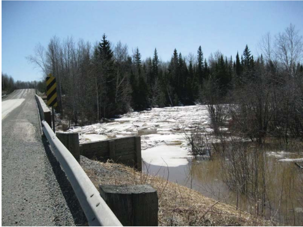
Photo 8.10a 30 avril 2011 - Pont chemin Roulier (PK 22+150) – côté amont ( Q=50 \text{ m}^3/\text{s} ).
