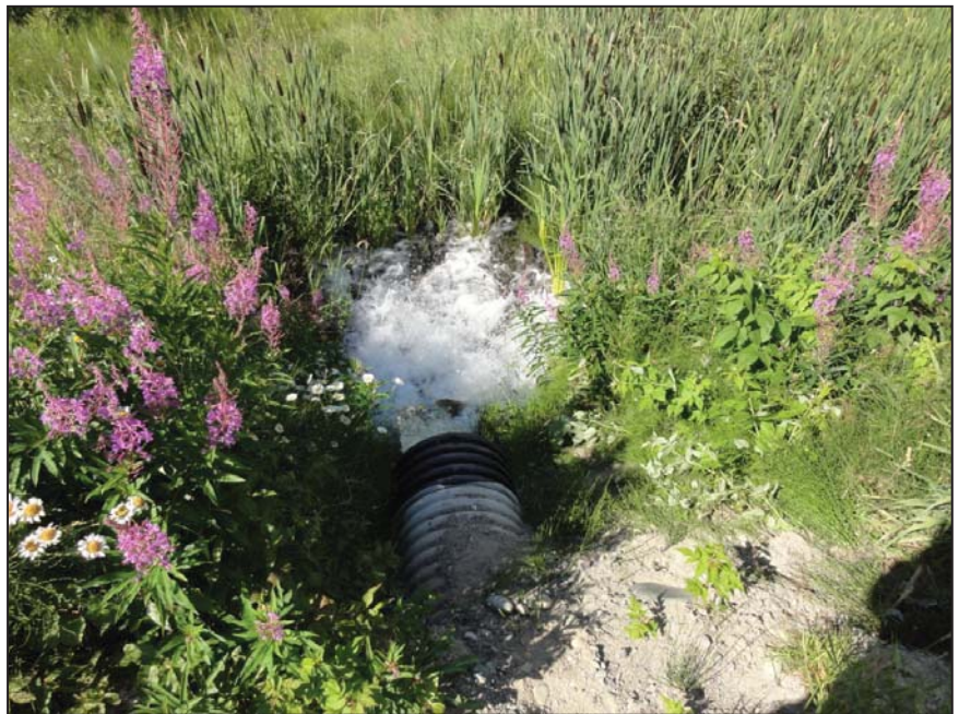
Photo 6 Extrémité aval du ponceau
