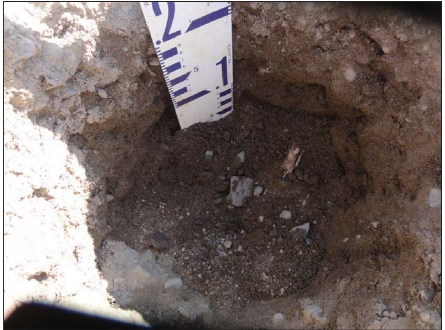
Photo 5 Granulométrie de la digue au droit du ponceau PEHD 450 mm de diamètre.
