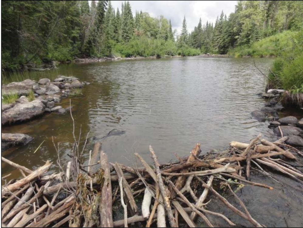
Photo A7.3 Barrage au PK 43+100 (en amont du rapide #2).
