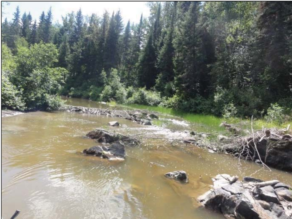
Photo A7.22 Barrage au PK 19+440.
