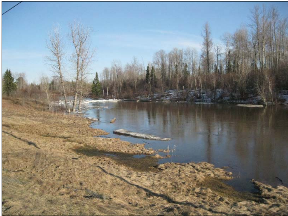
Photo 8.7a 30 avril 2011 – Pont de la route 111 – Rivière Villemontel (PK 44+227) ( Q=50 \text{ m}^3/\text{s} ).
