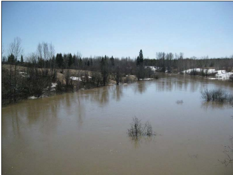
Photo 8.11a 30 avril 2011 – Pont 8 e /9 e rang (PK 17+150) – côté aval ( Q=50 \text{ m}^3/\text{s} ).
