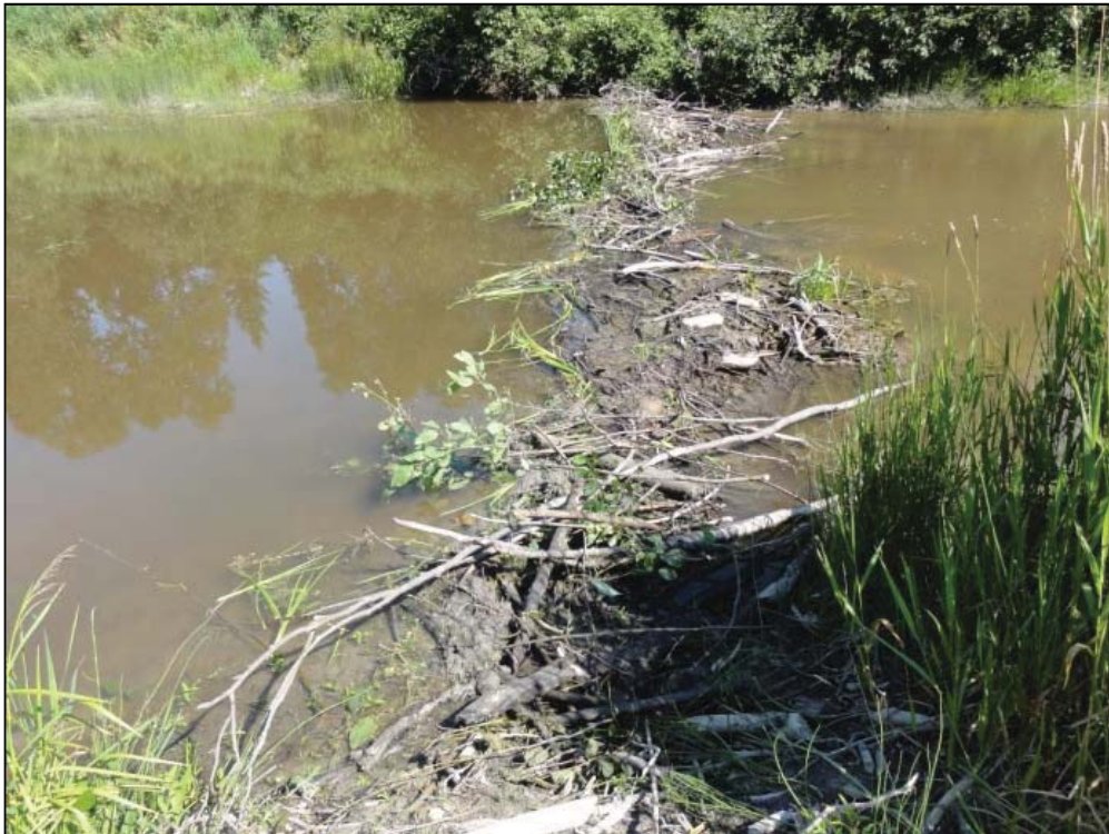
Photo A7.20 Barrage au PK 22+560.
