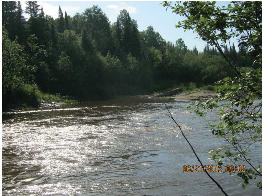
Photo 16 Ancien ponceau échoué en aval dans la rivière Octave
