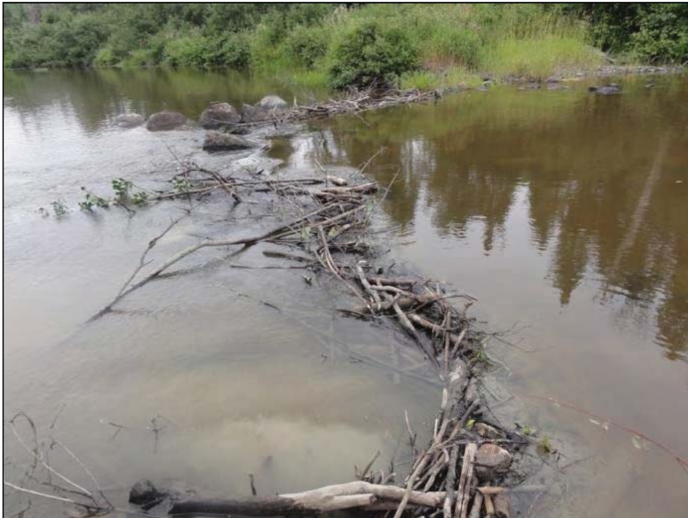
Photo A7.16 Barrage au PK 25+040.
