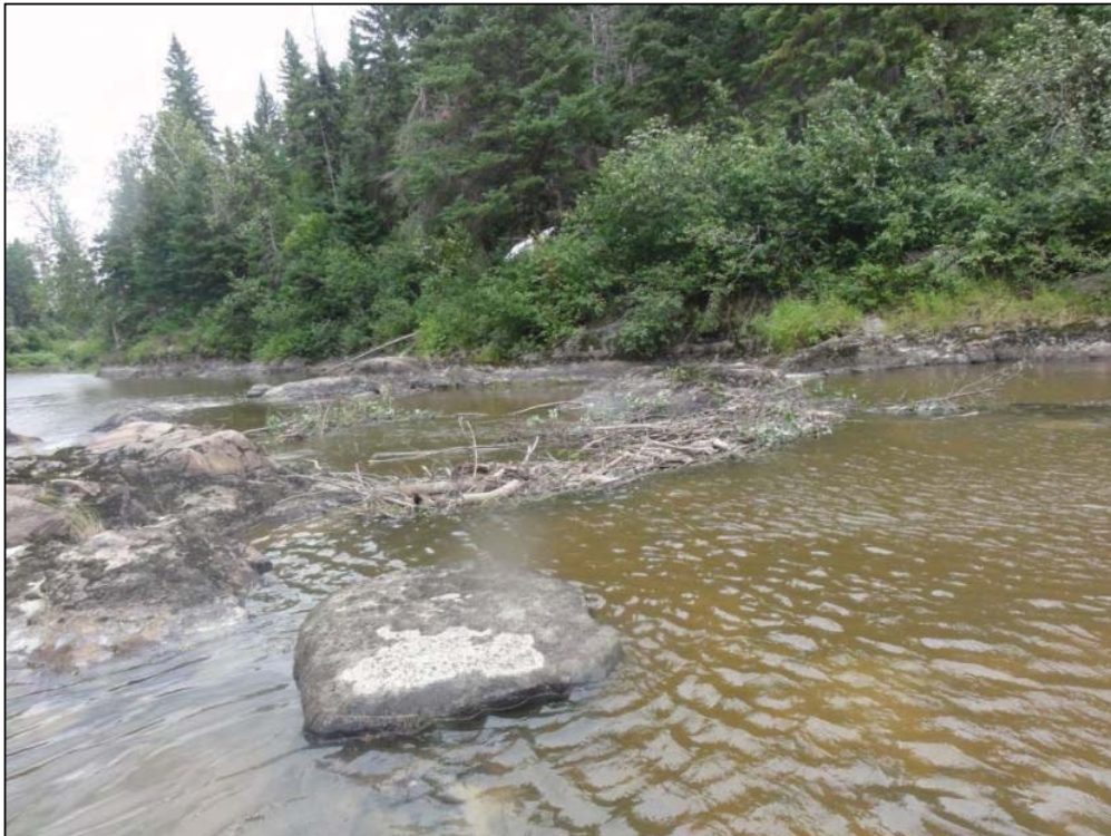
Photo A7.18 Barrage au PK 23+500 (en amont du rapide #7).
