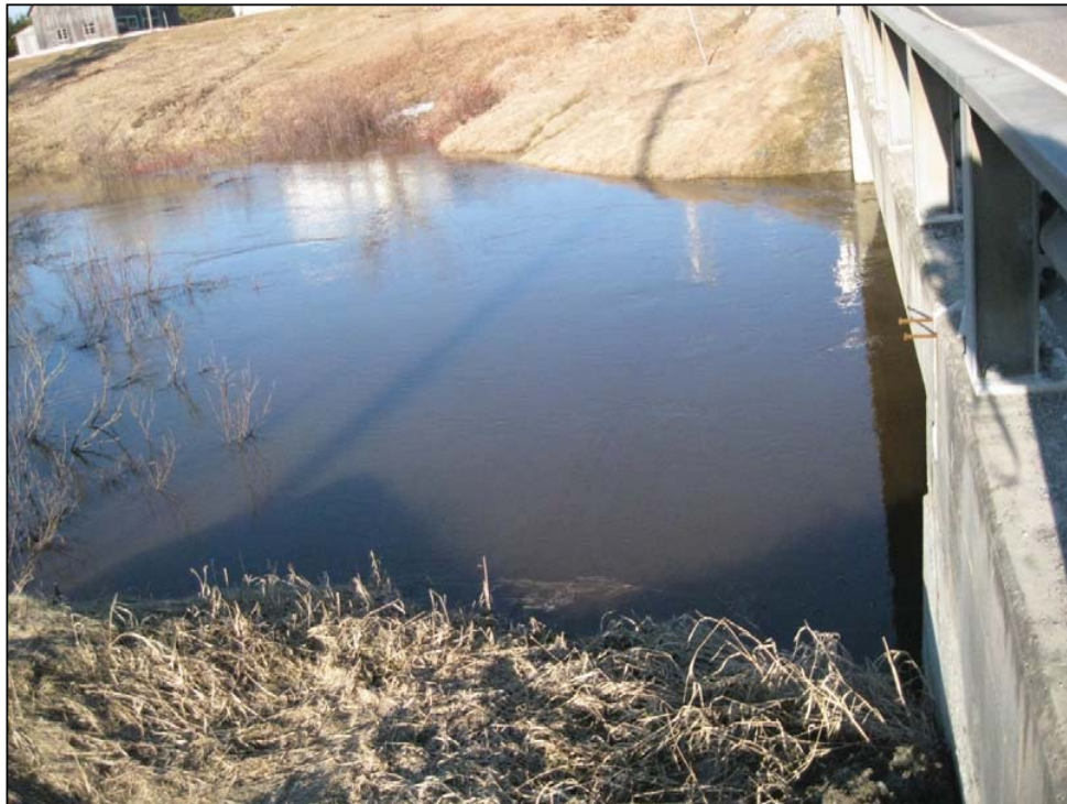
Photo 8.2a 30 avril 2011 – Pont de la route 111 – Confluence du ruisseau (PK 44+227) – amont.
