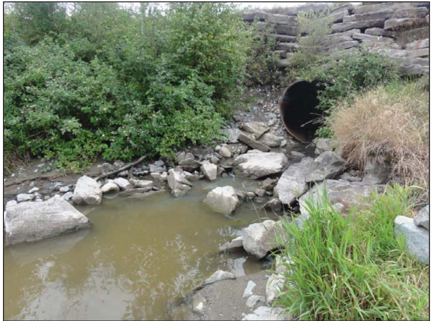
Photo 17 Émissaire pluvial/sanitaire #1 en amont du rapide
