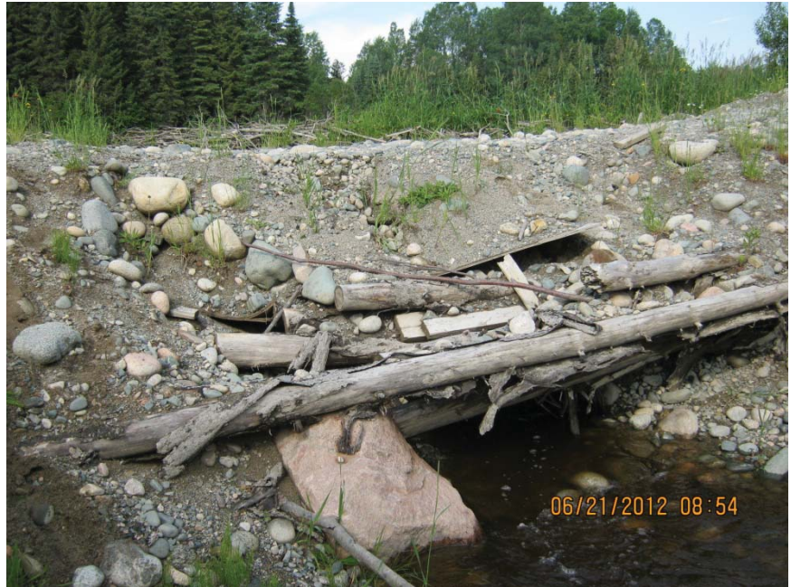
Photo 10 Aval du ponceau
