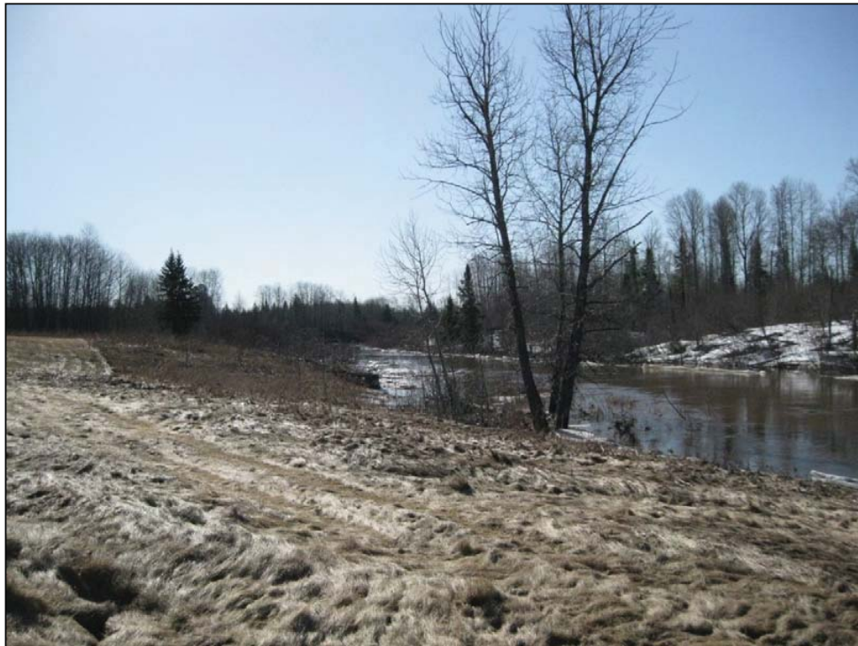
Photo 8.8a 30 avril 2011 – Pont de la route 111 – Rivière Villemontel (PK 44+227) ( Q=50 \text{ m}^3/\text{s} ).
