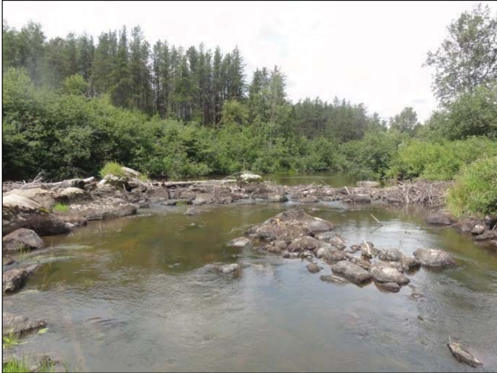
Photo A7.7 Barrage au PK 32+260 (en amont du rapide #4).
