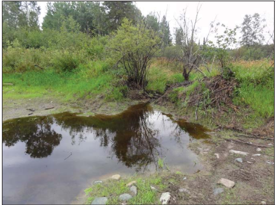
Photo 1 Digue à l'exutoire du système aquatique
