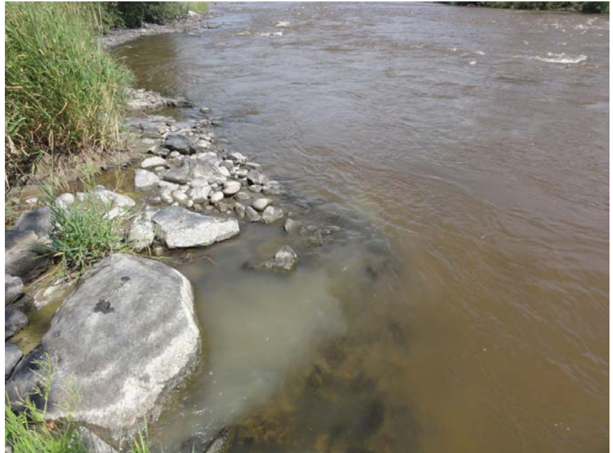
Photo 19 Émissaire pluvial/sanitaire #2 en amont du rapide
