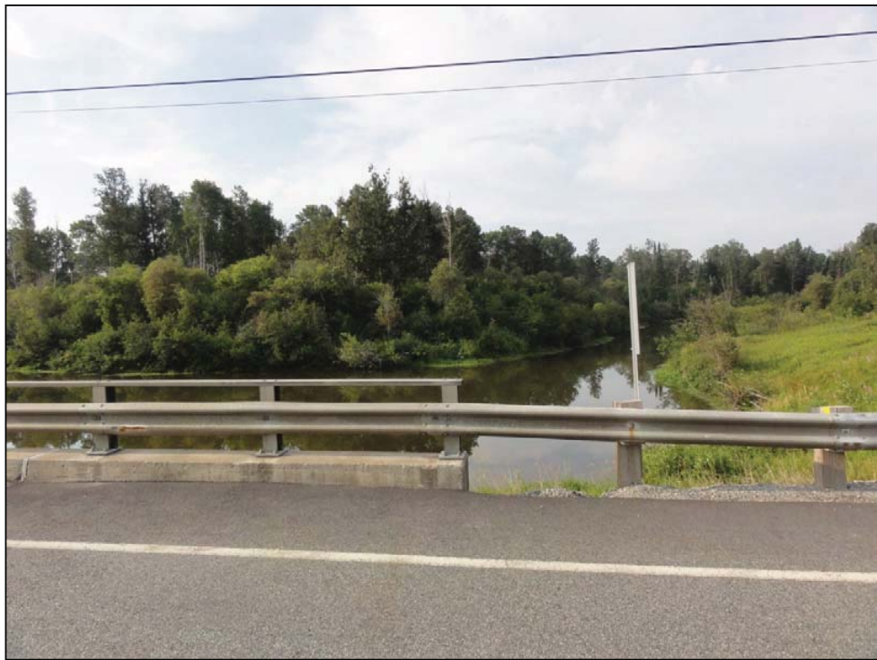
Photo 8.5b 2 août 2012 – Pont de la route 111 – Confluence du ruisseau (PK 44+227) – aval ( Q=0,5 \text{ m}^3/\text{s} ).
