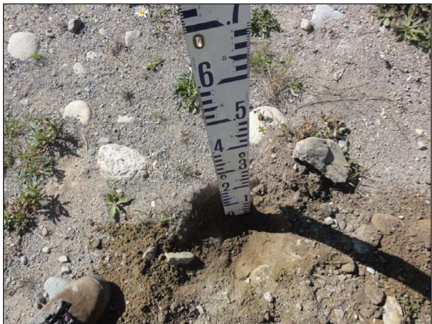
Photo 4 Granulométrie de la digue au droit du ponceau PEHD 450 mm de diamètre.
