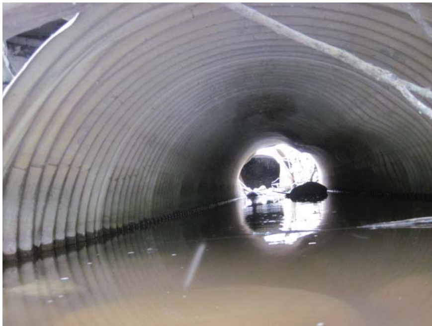
Photo 12 Intérieur du ponceau – vue vers l’amont
