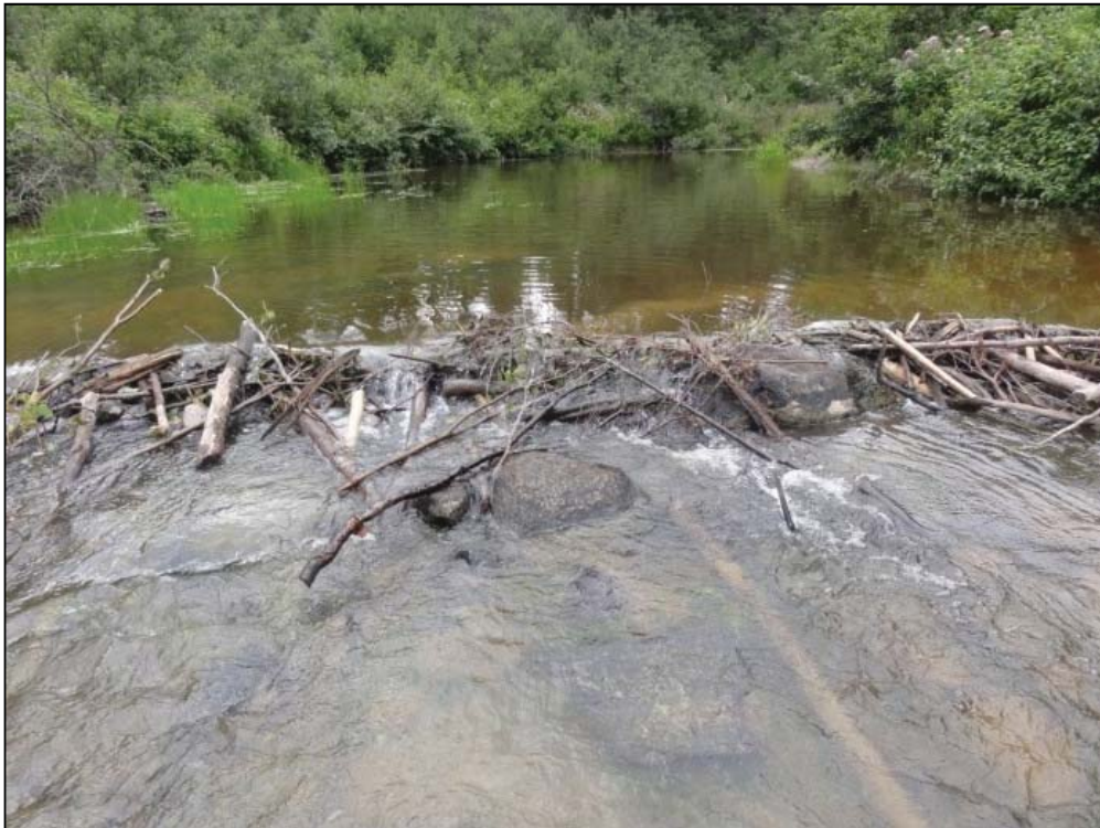
Photo A7.6 Barrage au PK 41+770.
