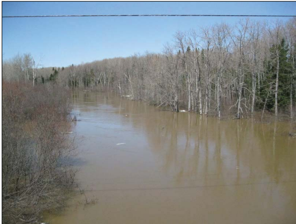
Photo 8.12a 30 avril 2011 – Pont 8 e /9 e rang (PK 17+150) – côté amont ( Q=50 \text{ m}^3/\text{s} ).
