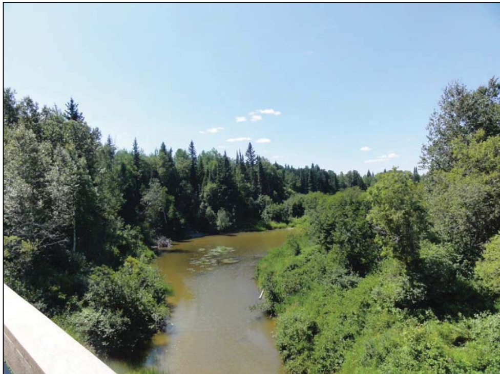
Photo 8.11b 30 juillet 2012 - Pont chemin Roulier (PK 22+150) – côté amont ( Q=0,5 \text{ m}^3/\text{s} ).
