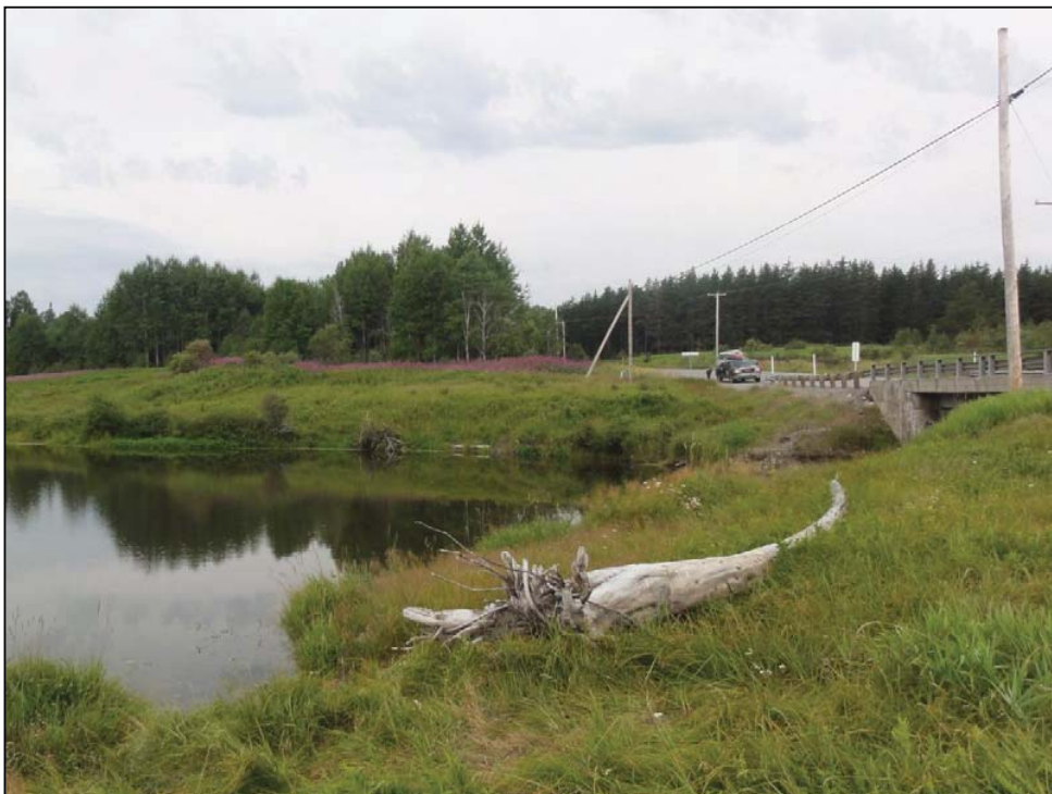
Photo 8.9b 2 août 2012 – Pont de la route 111 – Rivière Villemontel (PK 44+227) ( Q=0,5 \text{ m}^3/\text{s} ).
