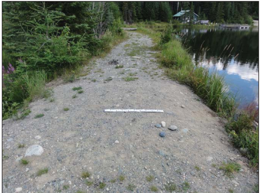
Photo 3 Petit remblai au droit du ponceau PEHD 450 mm de diamètre.
