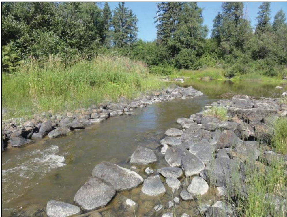
Photo A6.50 Rapide#8 : Rapide#8 : Vue vers l'amont. Présence de substrat en rive.
