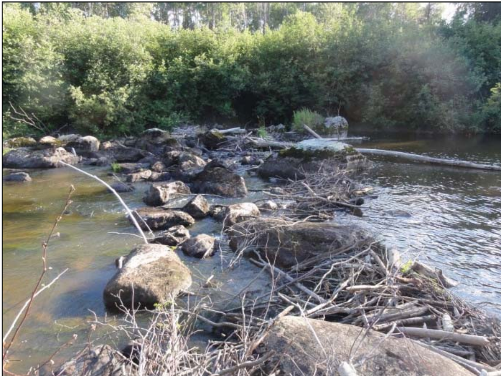
Photo A7.8 Barrage au PK 32+260 (en amont du rapide #4).
