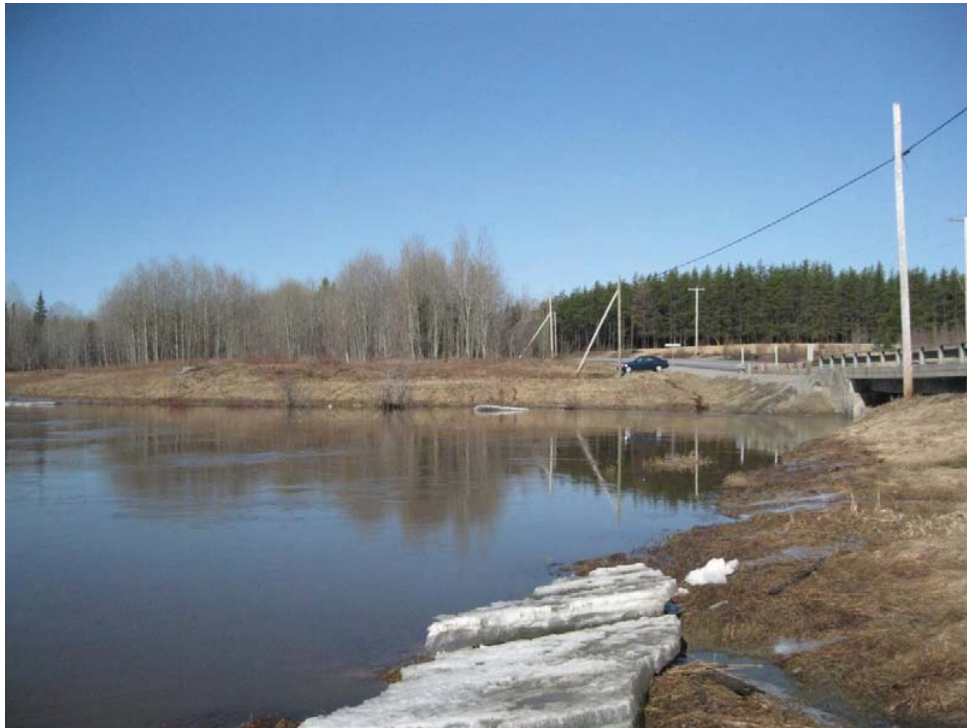
Photo 8.9a 30 avril 2011 – Pont de la route 111 – Rivière Villemontel (PK 44+227) ( Q=50 \text{ m}^3/\text{s} ).
