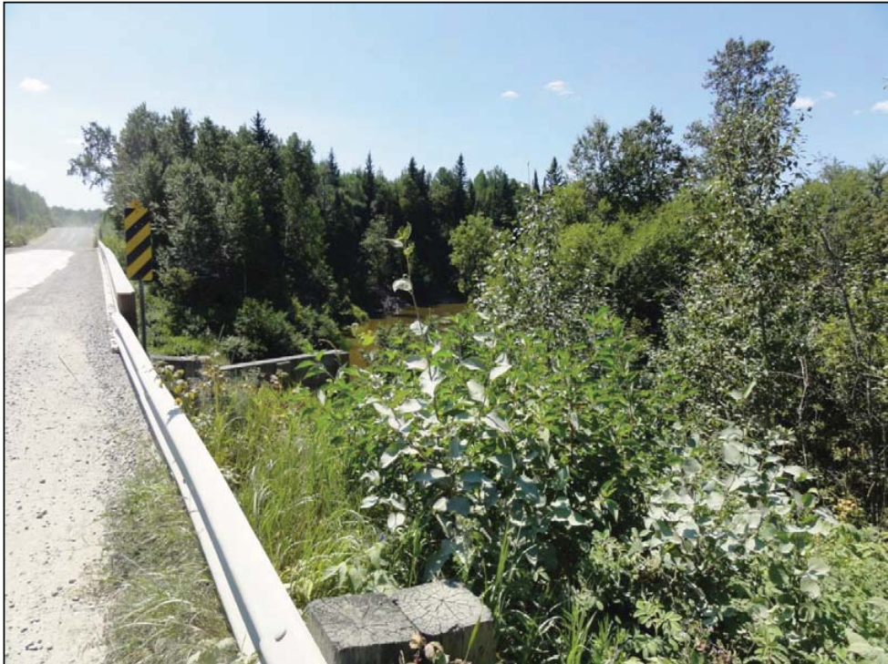
Photo 8.10b 30 juillet 2012 - Pont chemin Roulier (PK 22+150) – côté amont ( Q=0,5 \text{ m}^3/\text{s} ).
