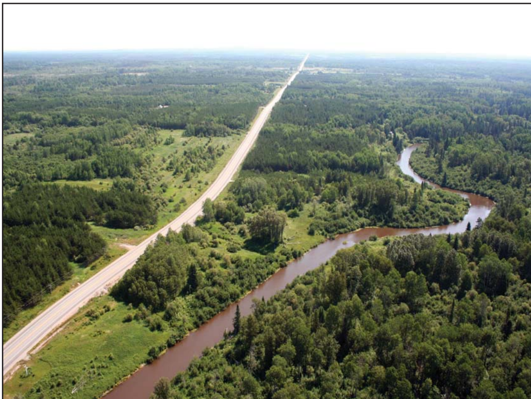
PHOTO 8 : Vue du tronçon de la rivière Villemontel en aval avec la confluence avec le ruisseau sans nom 1.
