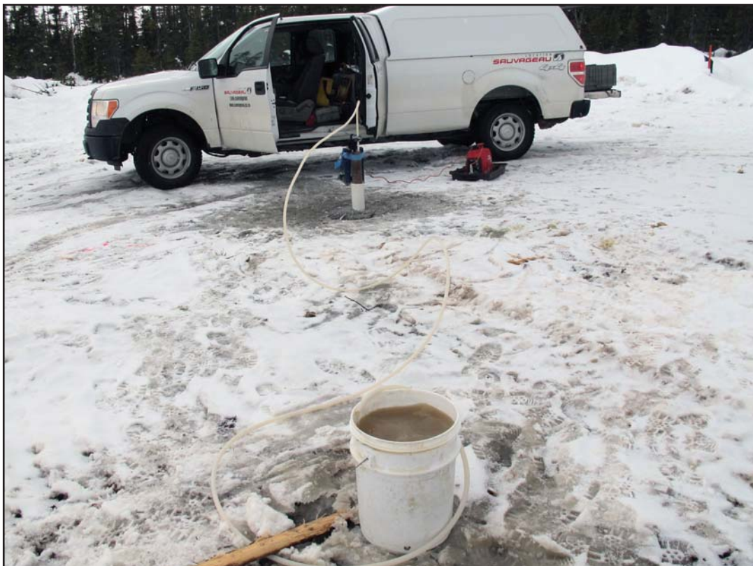
PHOTO 22 : Développement d'un puits d'observation des eaux souterraines.
