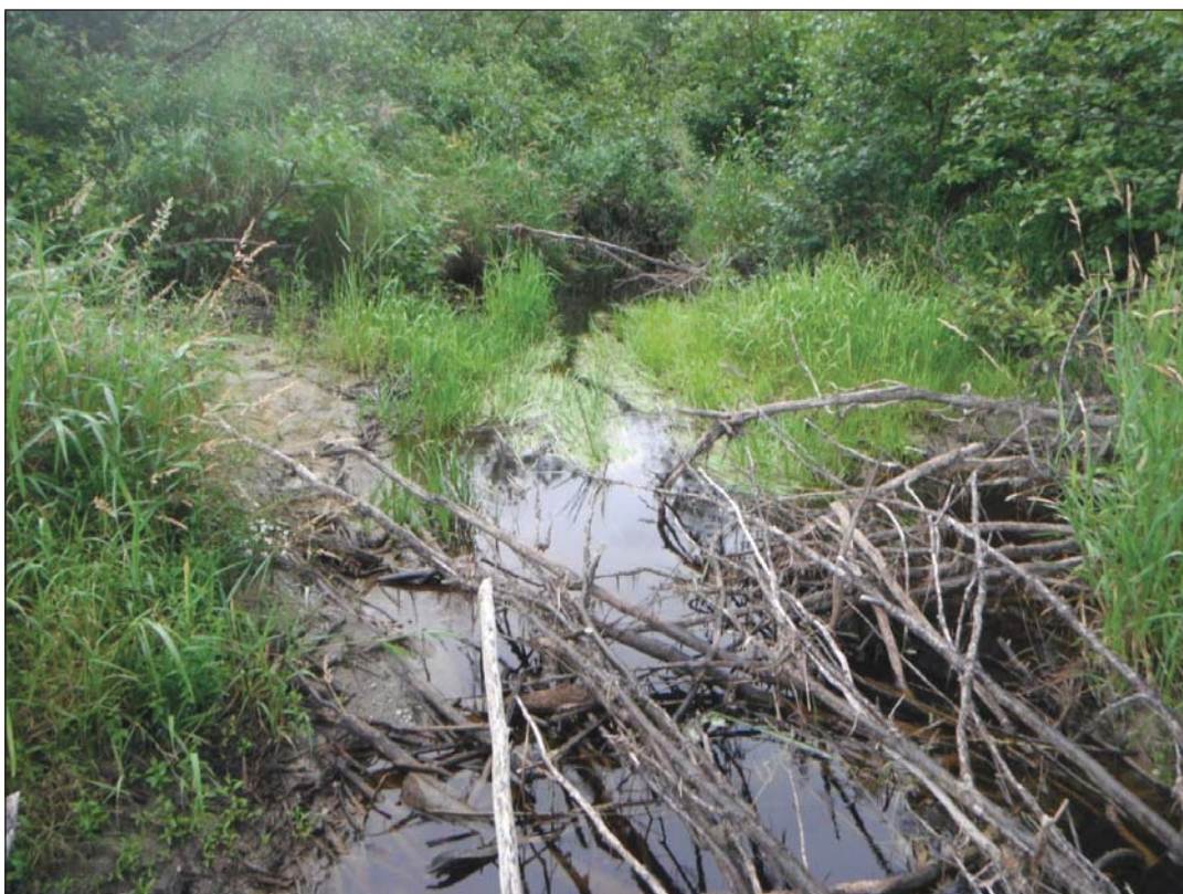
PHOTO 4 Débris de bois dans un cours d'eau situé au nord ouest du Lac à la Savane; 23/08/2011.
