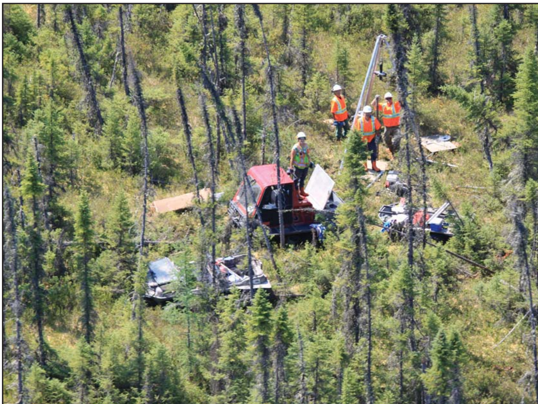
PHOTO 20 : Caractérisation des dépôts meubles au moyen d'une foreuse Metasonic.
