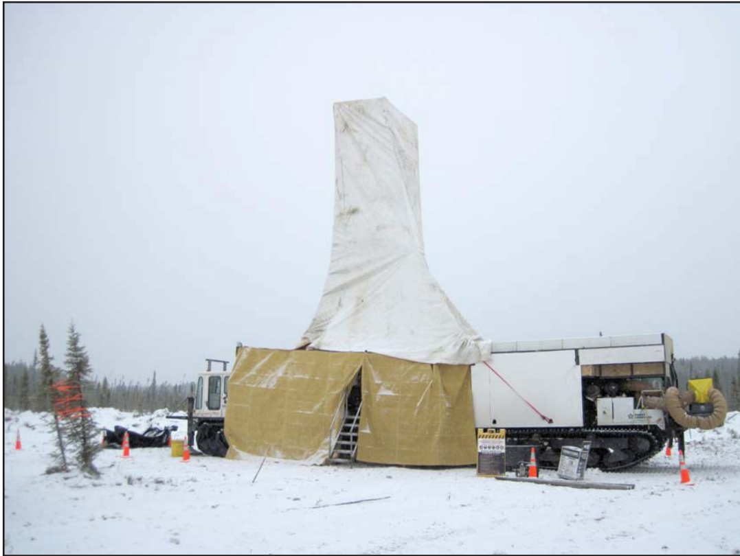
PHOTO 21 : Forage hivernal au moyen d'une foreuse Sonic pour l'aménagement de puits d'observation.
